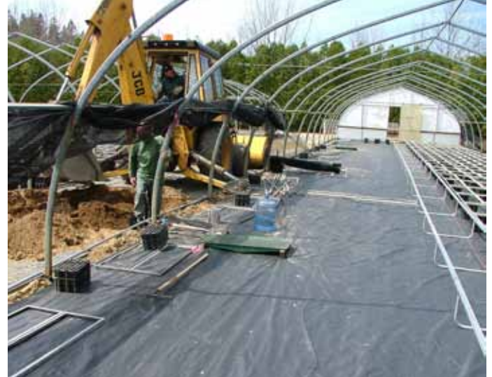
Installation de capteurs de lessivat sous une culture d'épinette blanche 1+0 produite dans le récipient 25-310 dans un tunnel de la pépinière de Grandes-Piles. Ce dispositif sur le lessivage des fertilisants vise à vérifier l'efficacité des paillis (résidus à rapports C/N élevés) à capter les fertilisants lessivés sous cette culture et assurer ainsi une protection accrue de la qualité des eaux souterraines en pépinières forestières. (D. Girard, MRNF).
