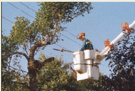
Tous les travaux de maîtrise de la végétation sur le réseau de distribution sont réalisés à l'aide de méthodes mécaniques.
