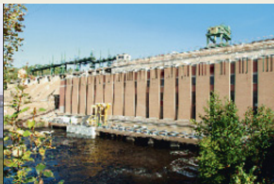
Centrale de La Tuque située sur la rivière Saint-Maurice.
