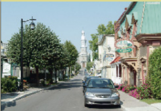
Quartier sans fils à Terrebonne, après la réalisation de travaux d'enfouissement du réseau de distribution.
