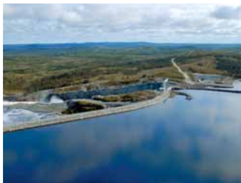
Site de l'Eastmain-1: le réservoir, le barrage et l'évacuateur de crues.
