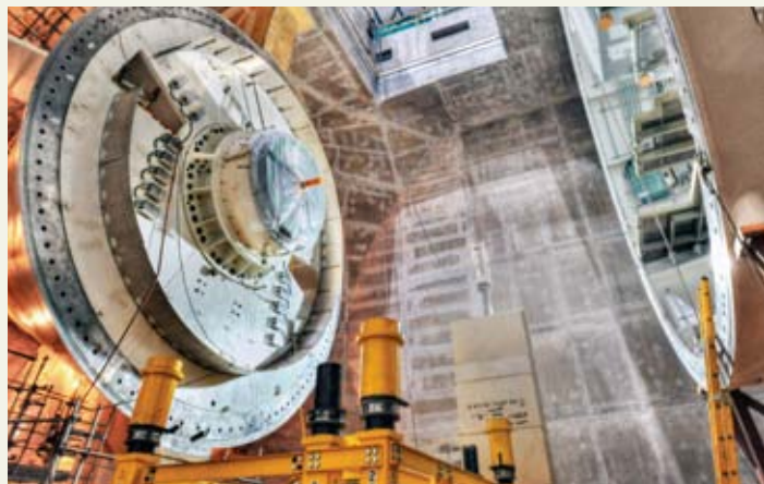
Installation d'une ogive dans le puits d'un groupe bulbe à la centrale de la Sarcelle, à la Baie-James. Un système de gestion environnementale certifié ISO 14001 encadre les activités sur le chantier.
