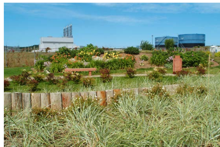
La centrale des Îles-de-la-Madeleine, la plus grande centrale thermique à moteur diesel du Québec. La transition énergétique aux îles entraînera une réduction considérable des émissions de GES.
