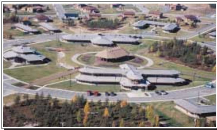
Édifices communautaires d'Oujé-Bougoumou. Désormais, ce sont les Crie eux-mêmes qui veilleront à l'implantation de telles infrastructures.
