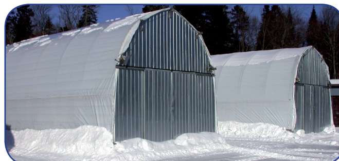
Figure 2. Deux tunnels cathédraux dont les toiles sont fermées durant l'hiver. La forte inclinaison des parois des tunnels limite les opérations de déneigement de la structure (photo F. Colas).
