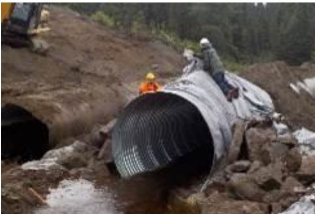
Installation des ponceaux à sec en alternance. Photo : MFFP
