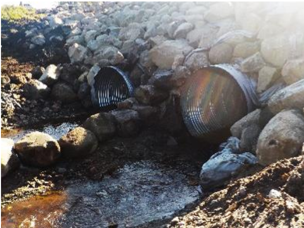
Traverse en amont du cours d'eau, une fois l'ouvrage terminé. Photo : MFFP
