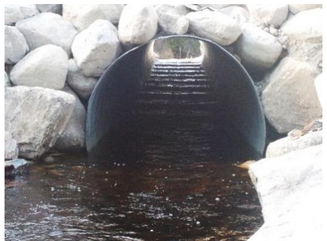
Circulation de l'eau en tout temps dans le conduit muni de déversoirs. Photo : MFFP
