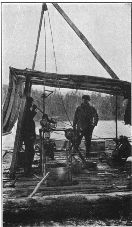
Forages de recherche dans le lit de la rivière.
