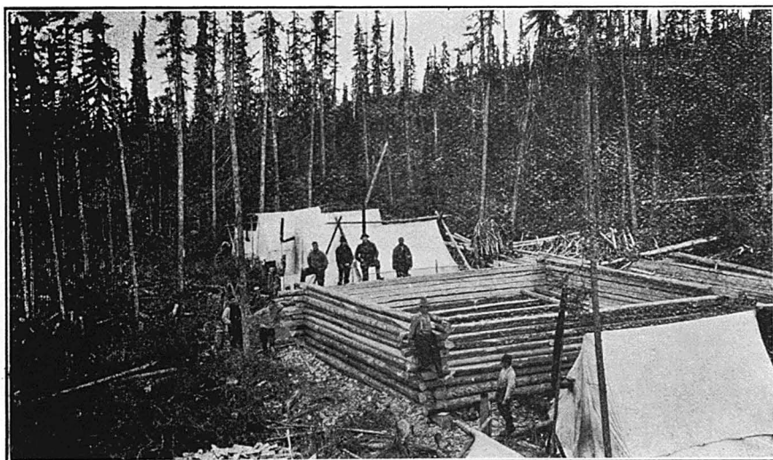
Cuisine en construction, mai 1913.
