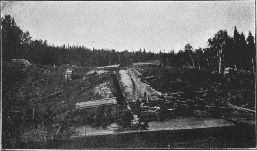
Tranchée sur la rive ouest.
