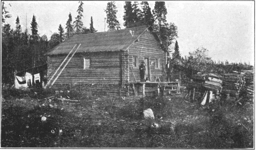
Bureau des ingénieurs.
