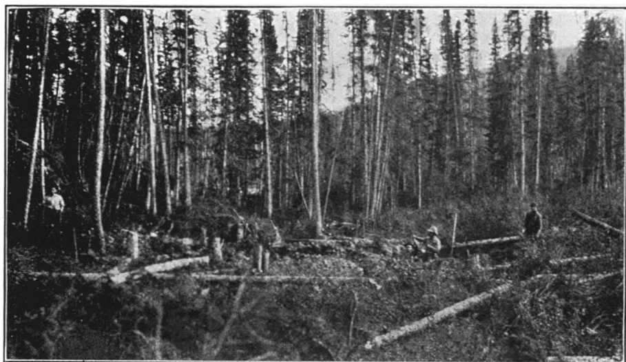
Extrémité est du barrage et du déversoir.
