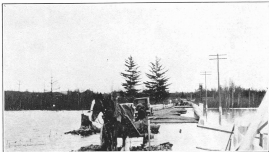
Petit lac Magog. Affouillement sur route Sherbrooke-Montréal, à Lake Park. 6 novembre 1927.
