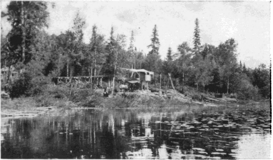
A.—Claims de Northwestern Quebec Prospectors, Limited. Installation de traitement de minerai système Nutt, sur le bord du lac Bousquet, canton de Bousquet (juillet 1933).
