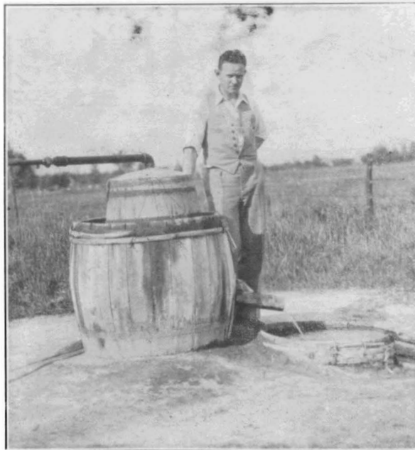
B.—Gazomètre domestique de gaz naturel sur un puits de 300 pieds de profondeur, alimentant une ferme; lot 396 du cadastre,
