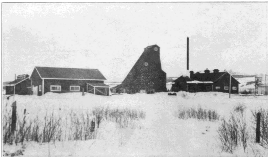
A.—Le puits No 2 de la mine Arntfield, canton de Beauchastel, mars 1935.
