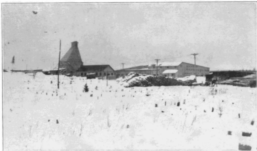
A.—Le puits incliné No 6 et l'atelier de traitement de la mine Lamaque, canton de Bourlamaque, février, 1935.
