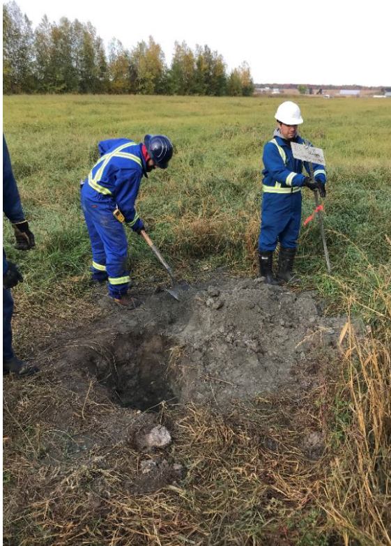
Figure 2 : Vue générale du site au 10 octobre 2019.
