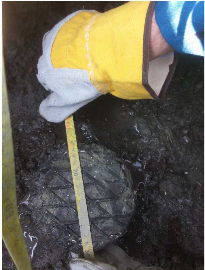
Figure 3 : Vue du tubage de 142,0 mm et le couvercle de métal à la surface du puits le 21 septembre 2020. Source : MERN.
