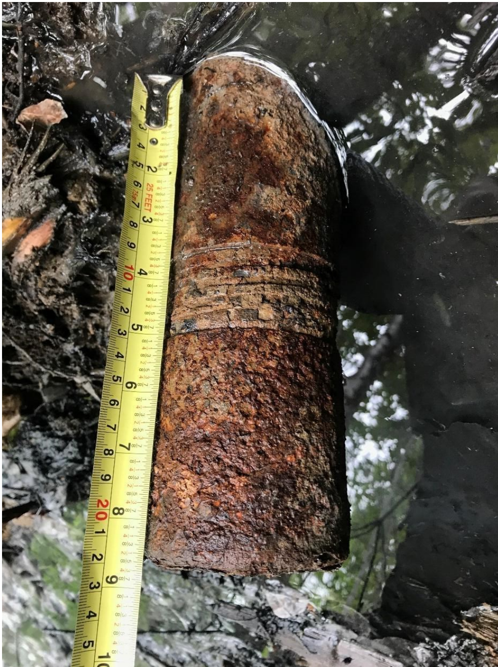
Figure 3 : Tubage de 88,9 mm du puits CS34. Source : Oea Experts-Conseils, 30 juin 2020.
