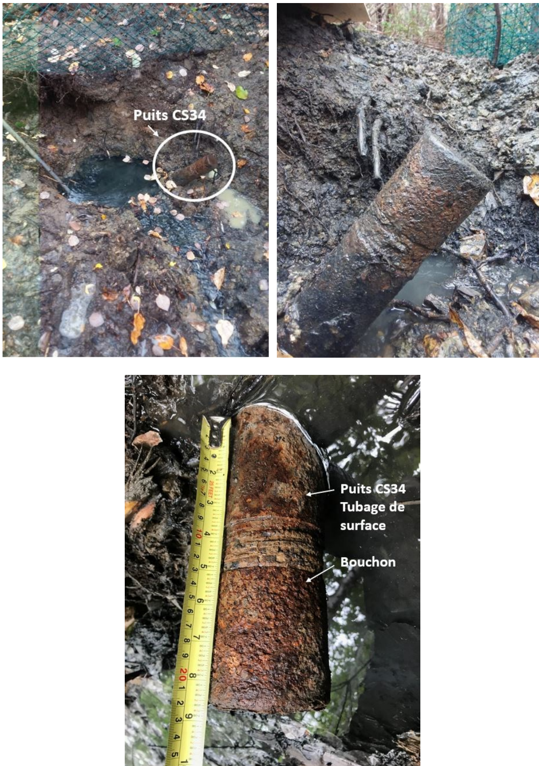
Figure 16 : Vues du tubage (octobre 2020).
