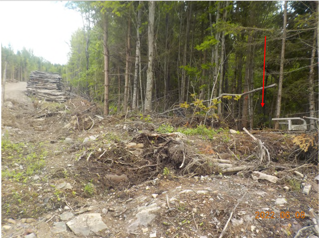
Figure 5: Emplacement des débris à ramasser
