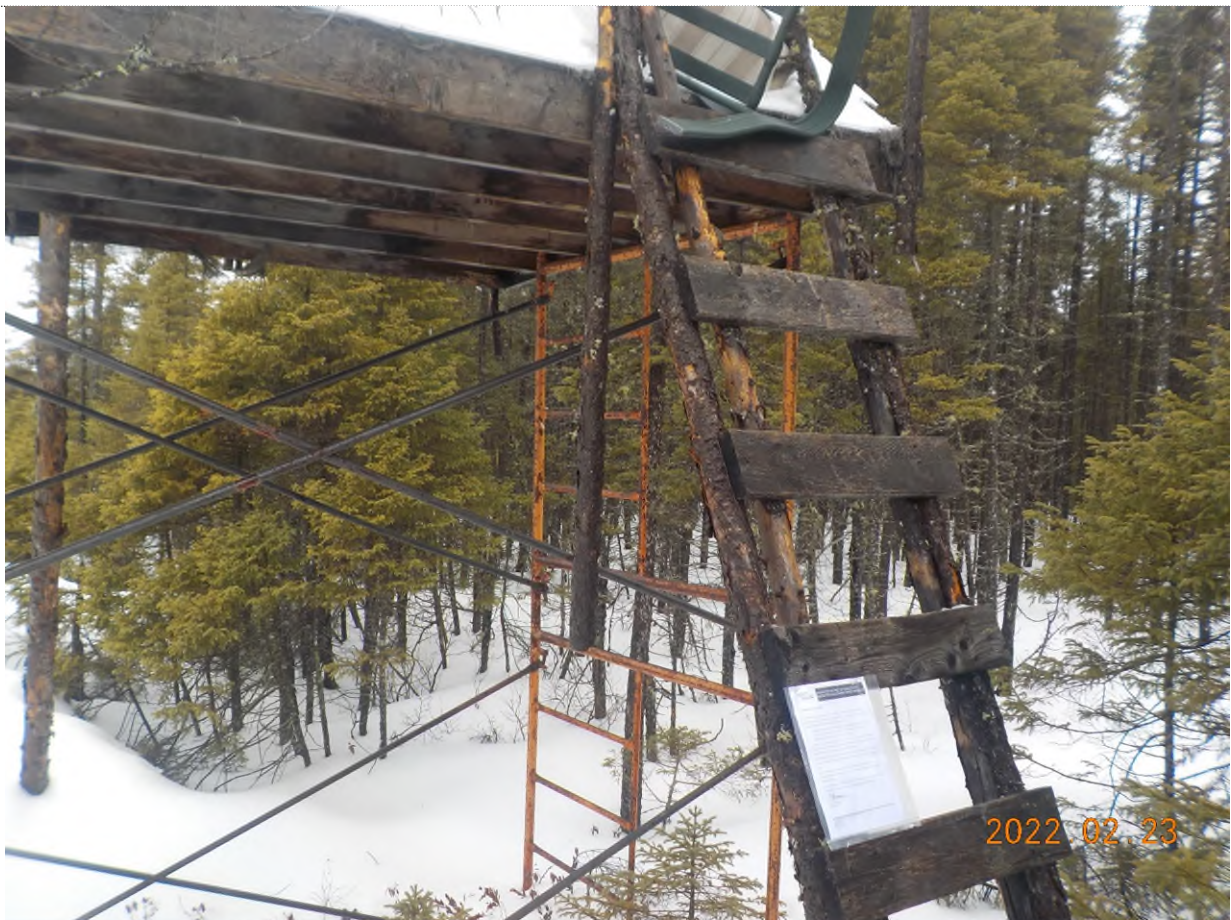
Figure 2 : Autre vue de la plateforme à démanteler.
