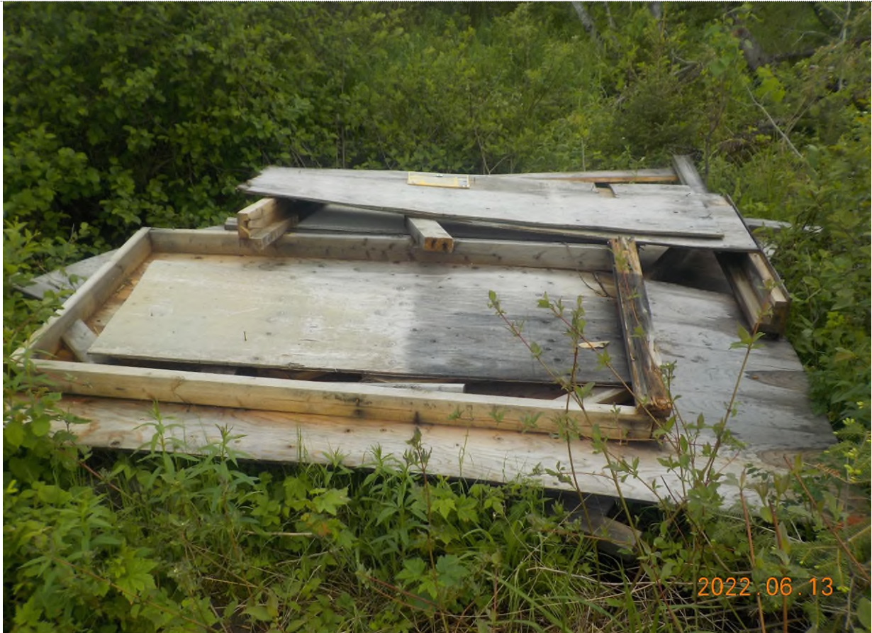
Figure 1: Éléments de la structure abandonnée à ramasser.
