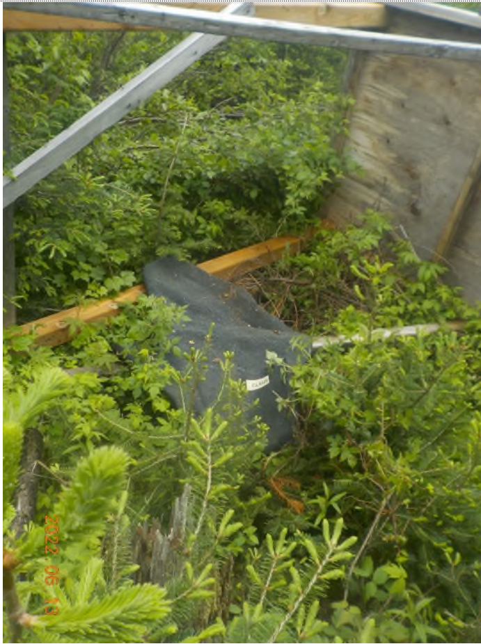
Figure 3: Débris à ramasser
