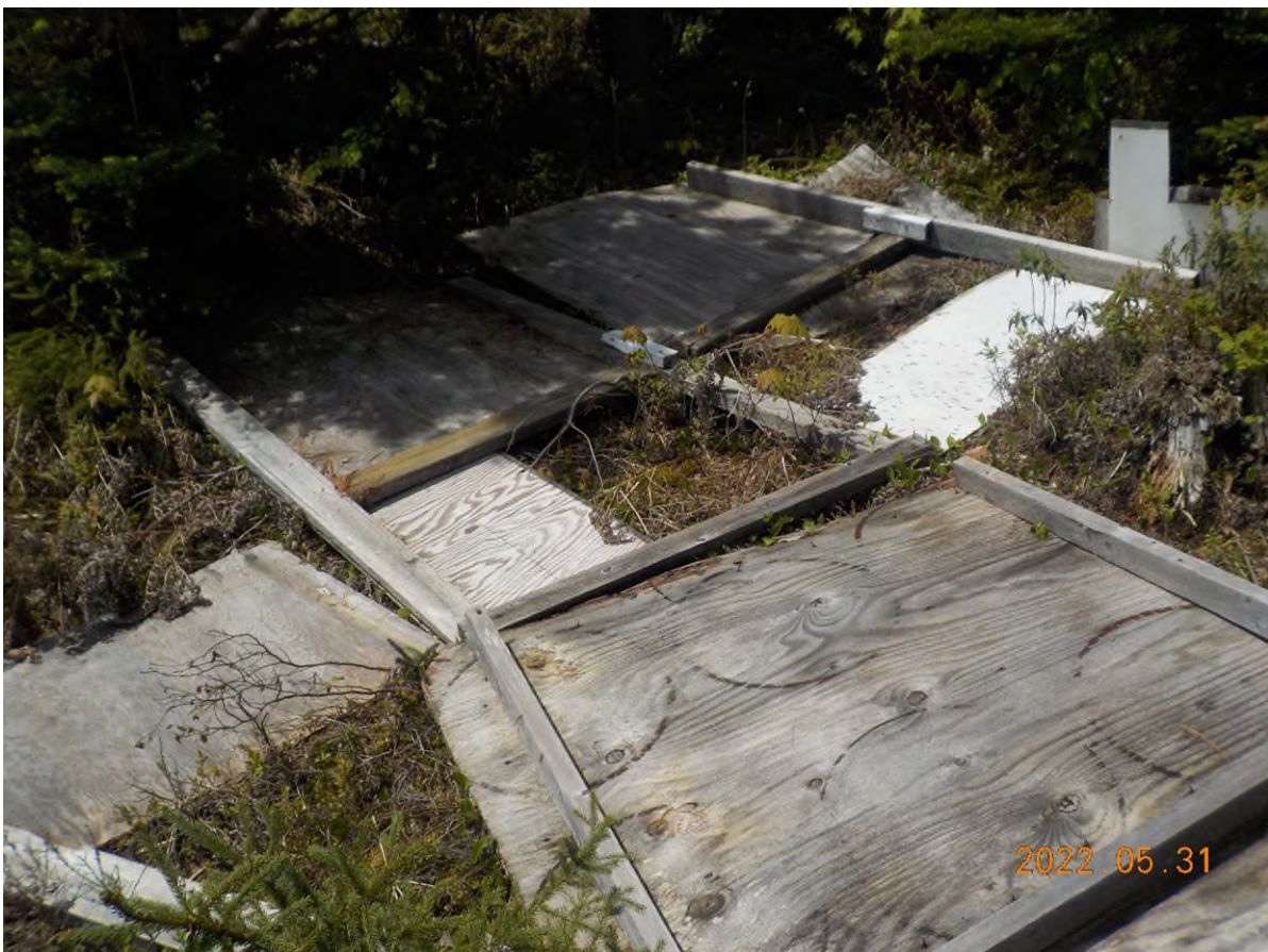
Figure 2 : Autres éléments de la structure abandonnée à ramasser.
