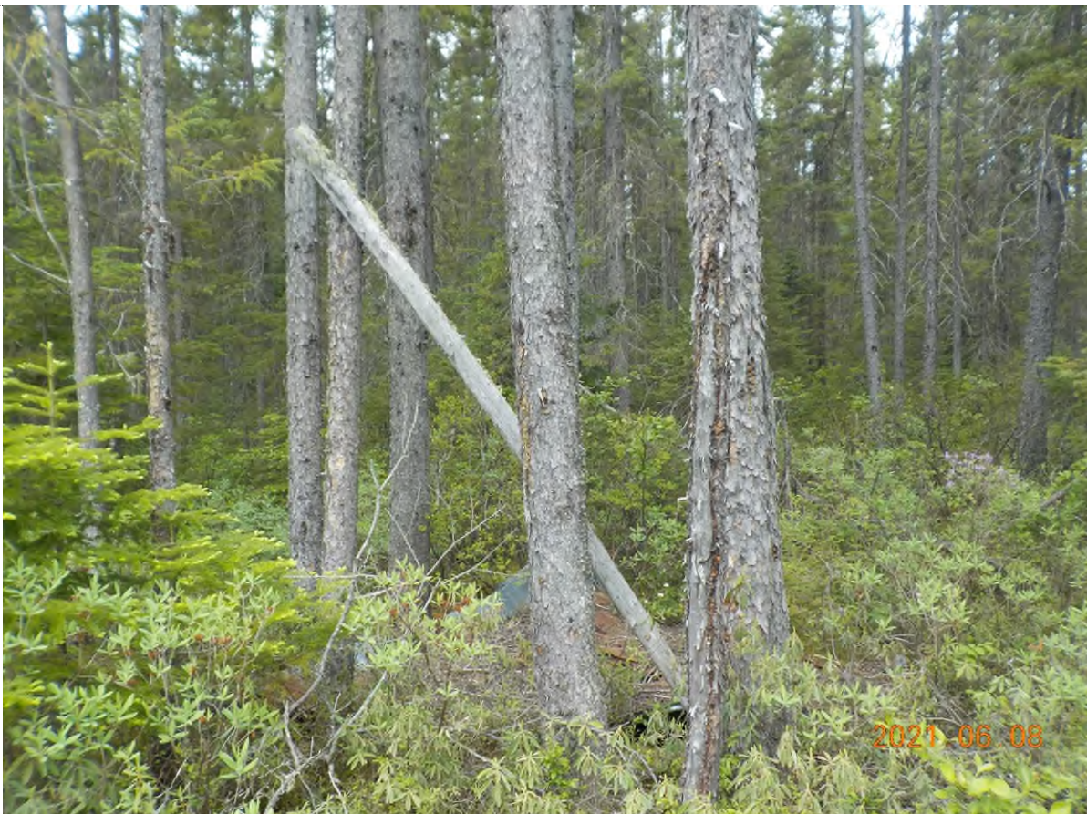
Figure 2: Vue d'ensemble de la structure abandonnée à ramasser
