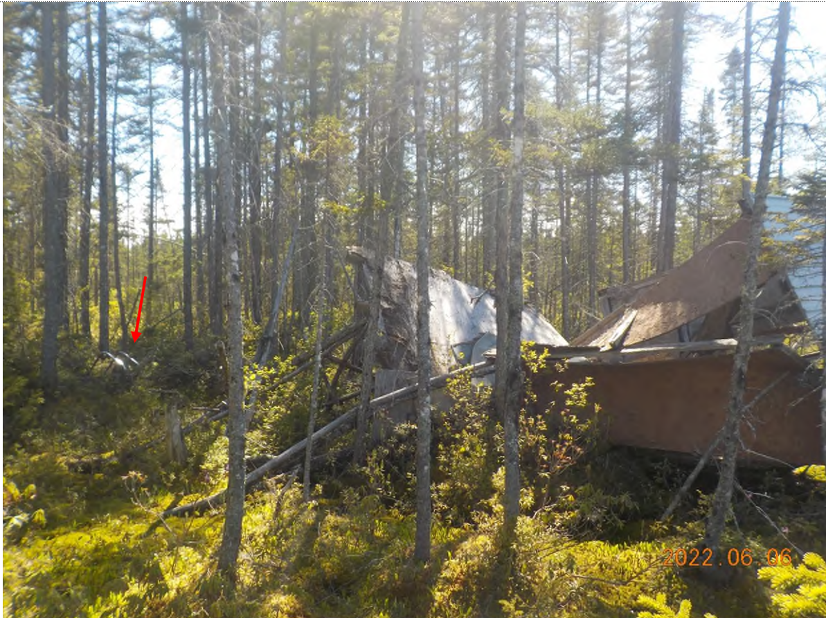
Figure 3: Structure écrasée à ramasser et débris à l'arrière
