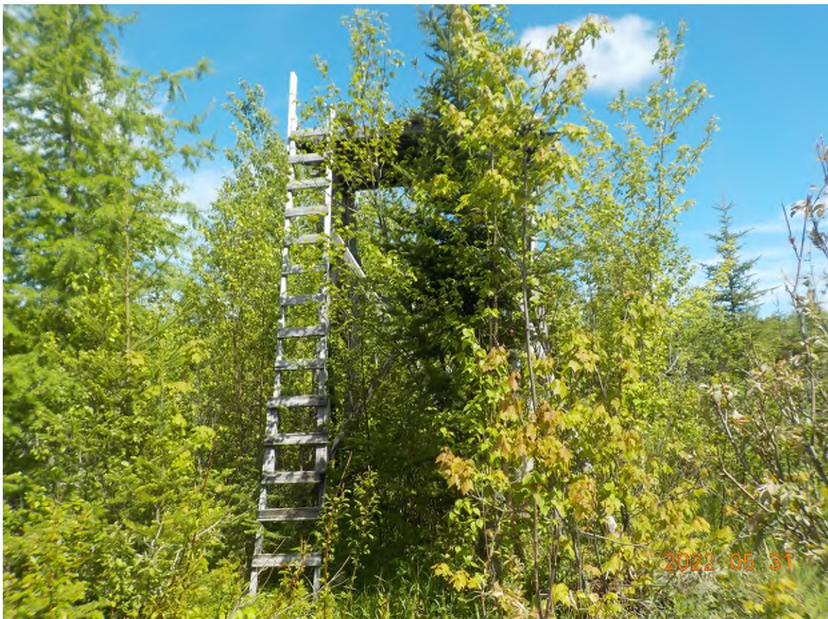
Figure 2: Autre vue de la plateforme à démanteler.
