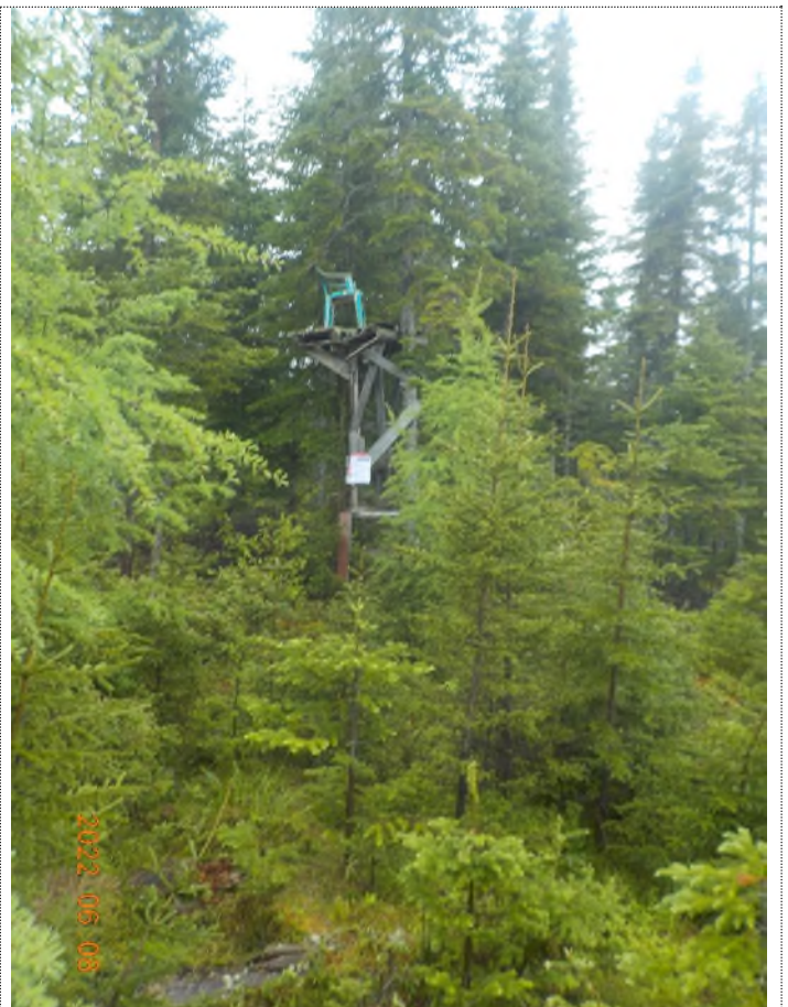
Figure 3: Plate-forme vue du chemin
