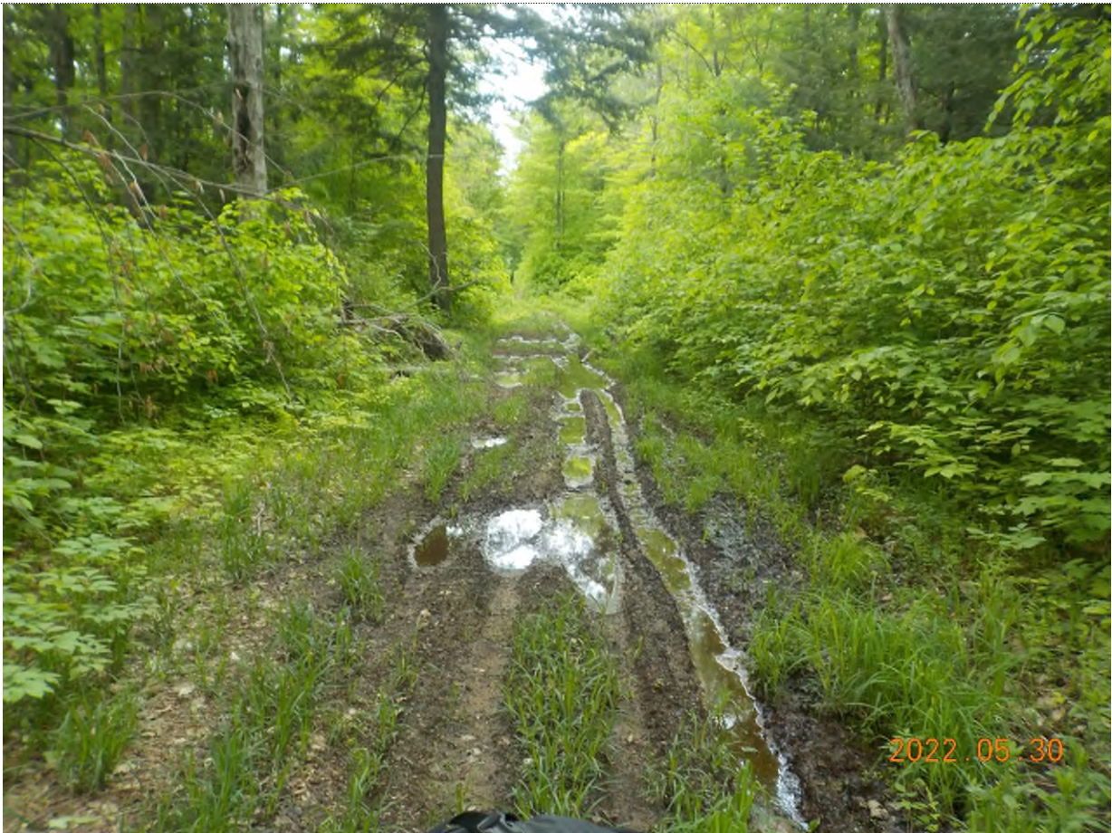
Figure 3: État du chemin VTT.
