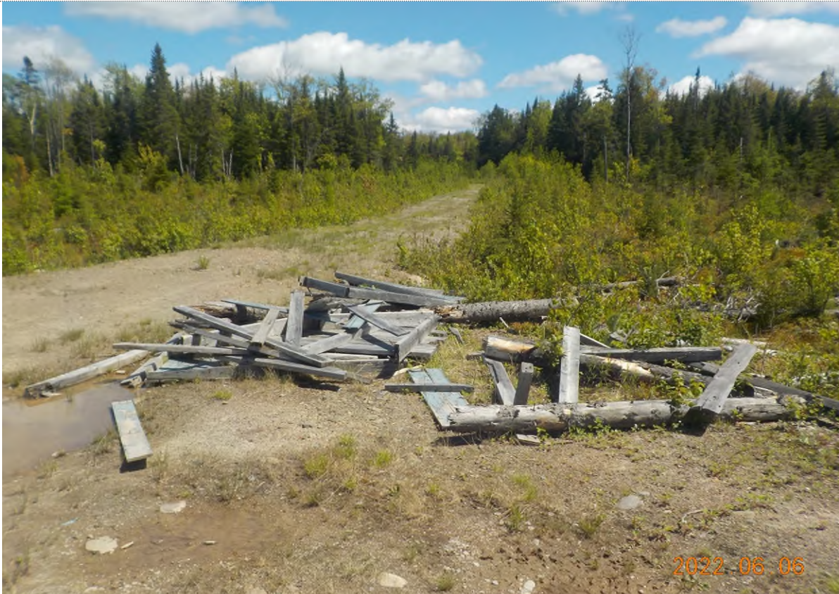
Figure 1: Débris à ramasser.
