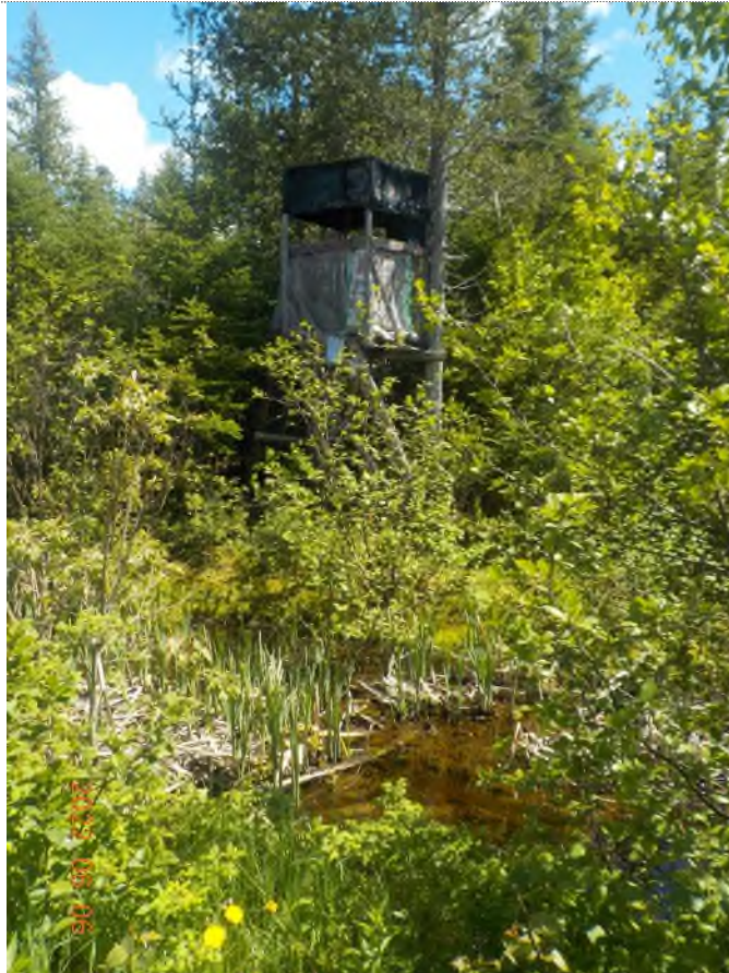
Figure 1: Tour de guet à démanteler de l'autre côté d'un fossé
