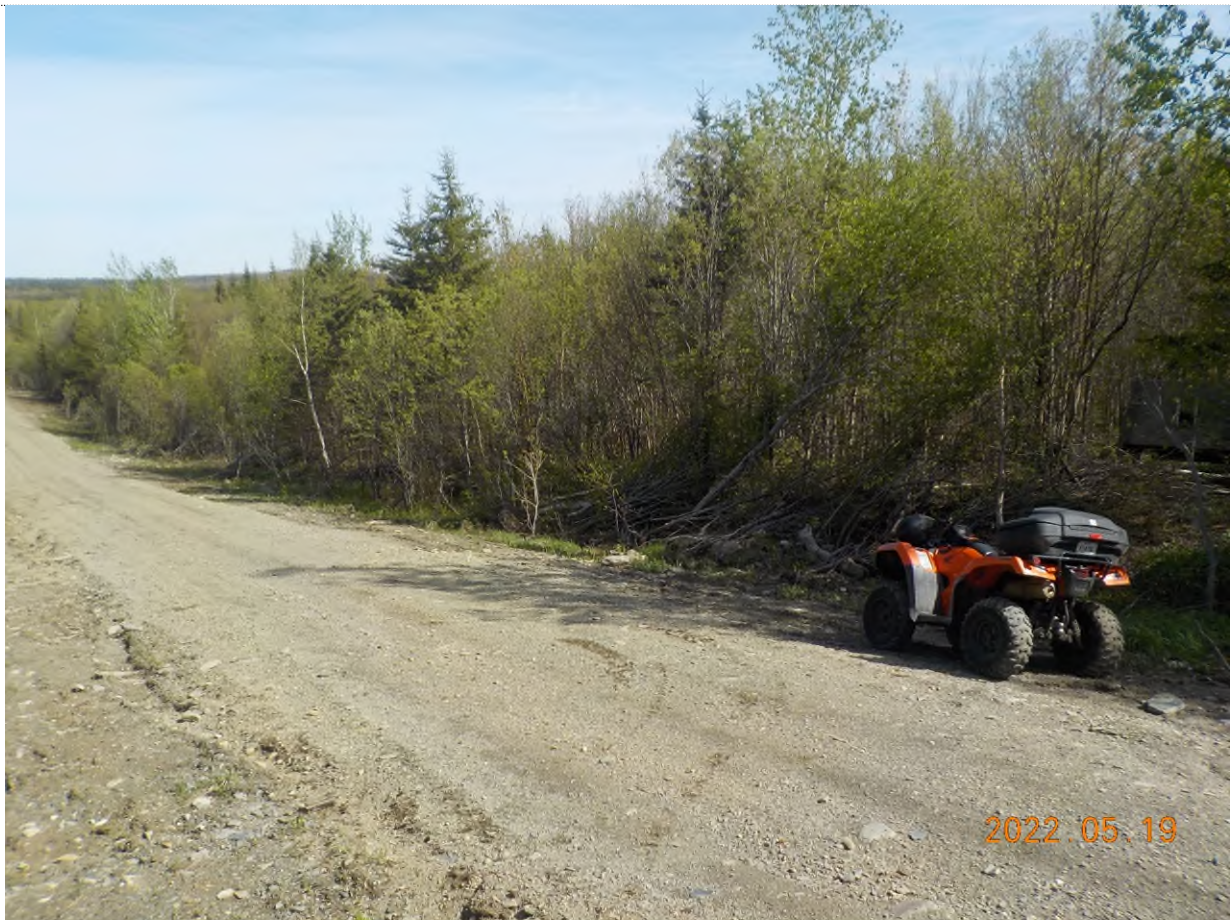
Figure 4: État du chemin forestier (structure à droite)
