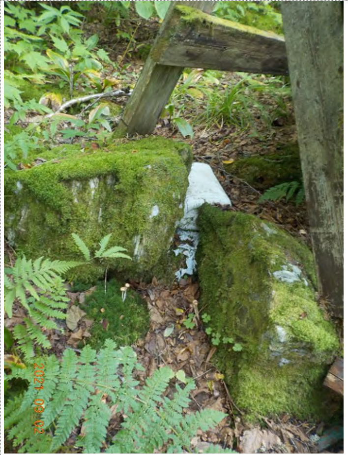
Figure 4: Débris à ramasser
