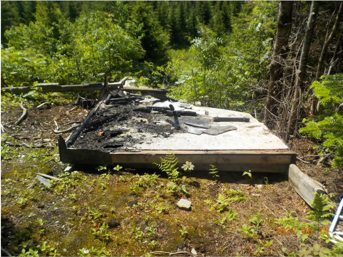
Figure 1: Plate-forme et débris à ramasser
