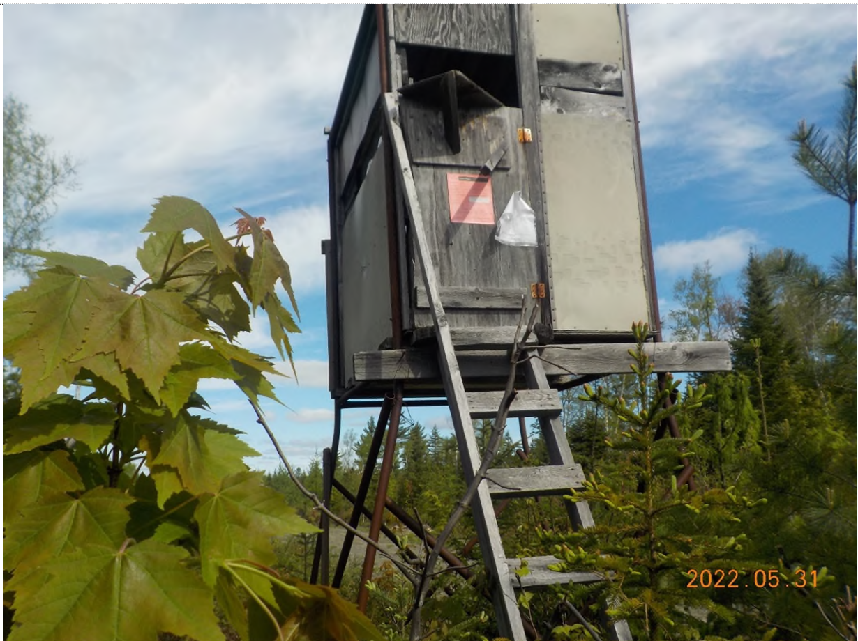
Figure 2: Autre vue de la structure à démanteler.
