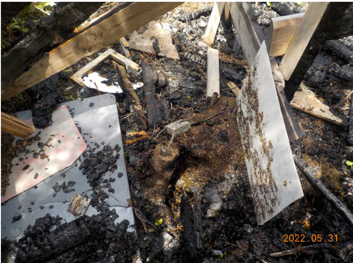
Figure 2: Vue rapprochée des débris à ramasser.
