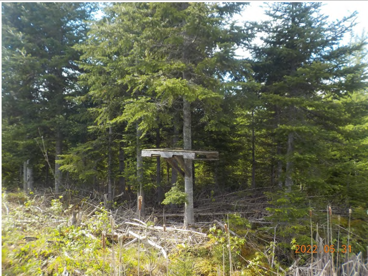
Figure 4: Structure au point supplémentaire à démanteler.
