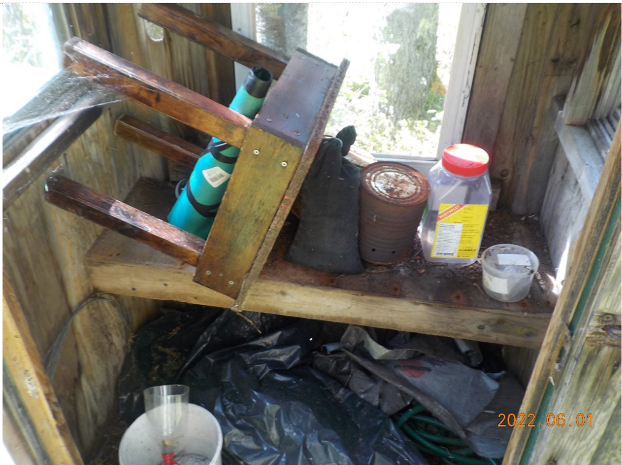
Figure 2: Débris dans la structure à ramasser
