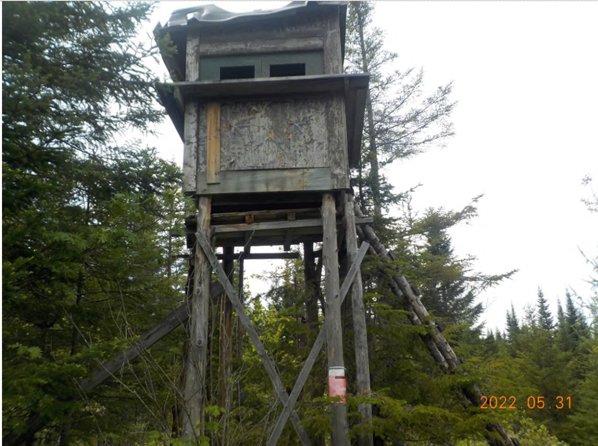
Figure 1 : Structure à démanteler.
