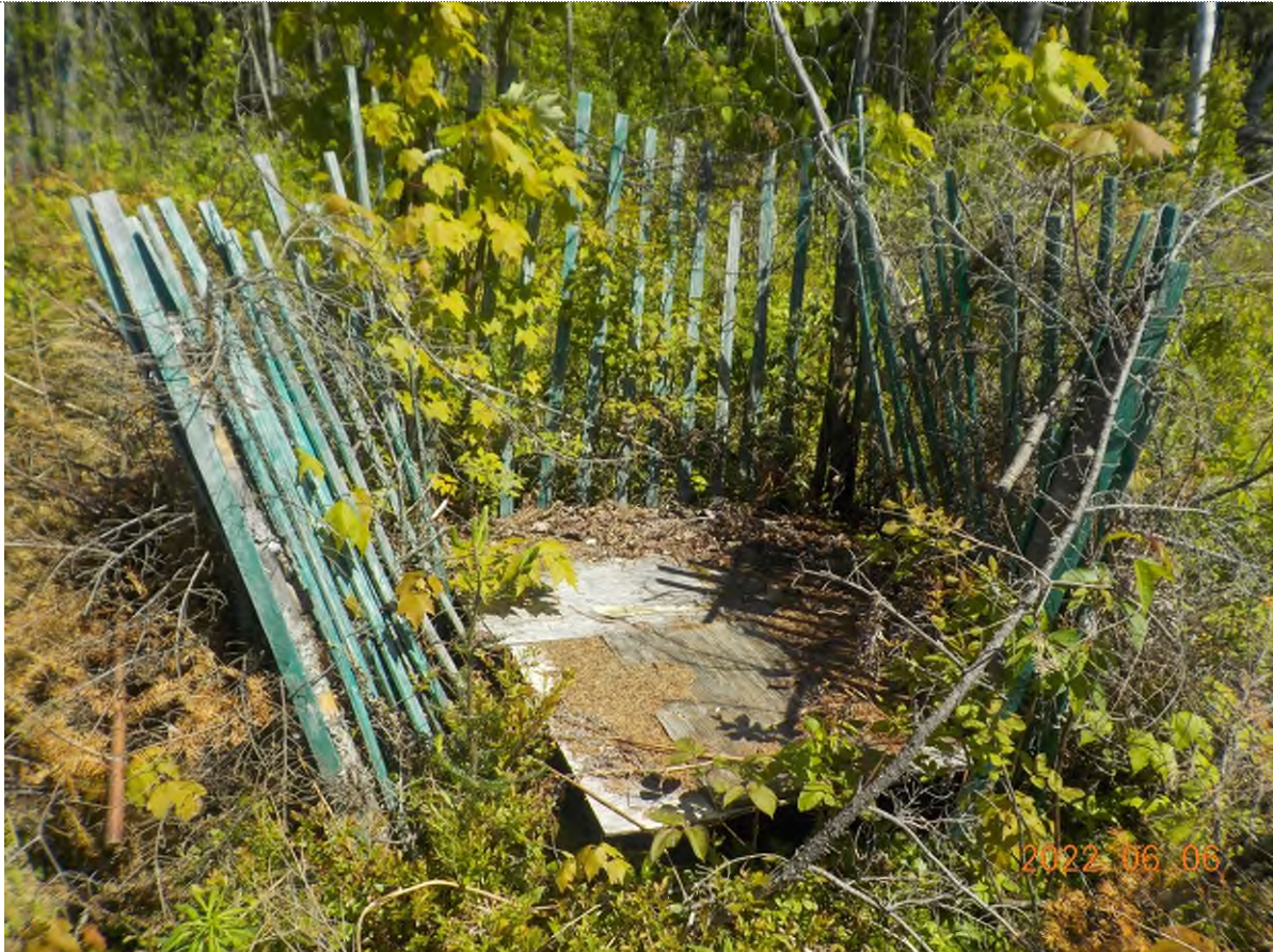
Figure 1: Débris à ramasser.
