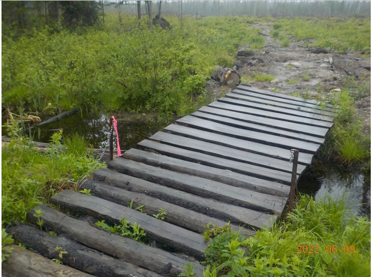
Figure 3: Pont VTT de la dernière section du chemin forestier d'hiver
