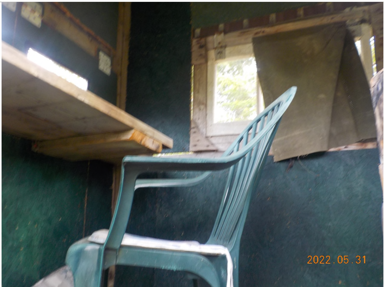
Figure 2 : Intérieur de la structure à démanteler.
