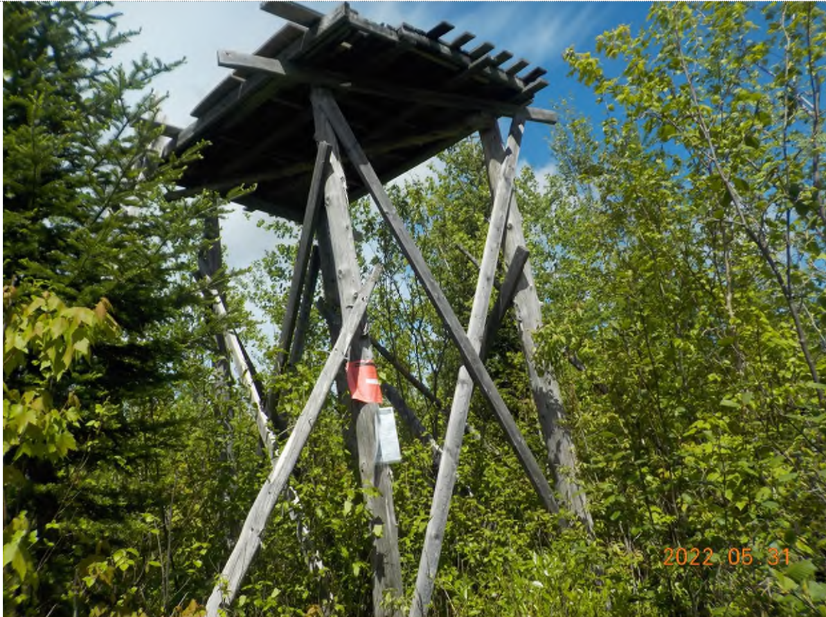
Figure 1: Plateforme à démanteler.
