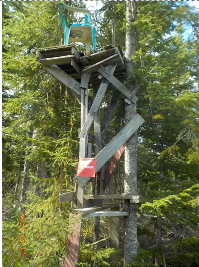
Figure 1: Plateforme à démanteler.
