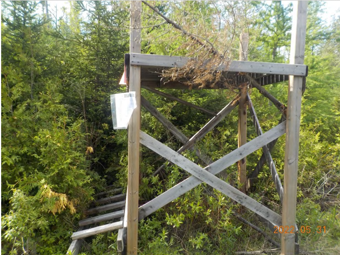
Figure 1: Plateforme à démanteler.
