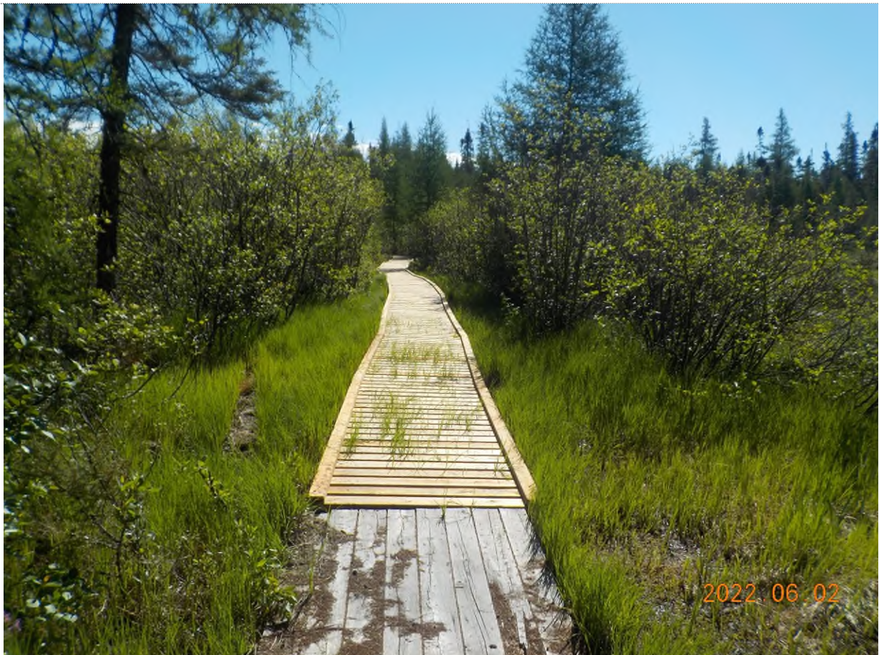
Figure 4: État du sentier récréatif (infrastructures pédestres)
