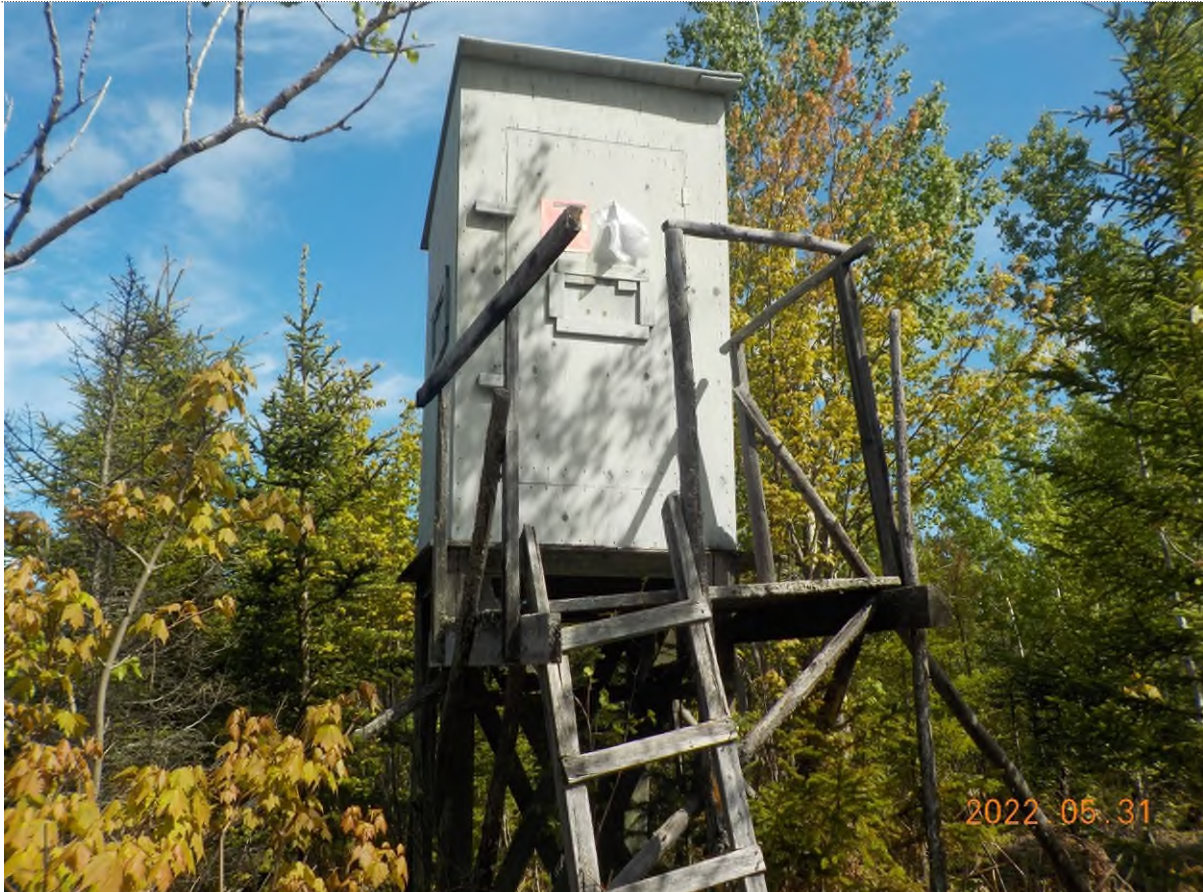
Figure 1: Structure à démanteler.
