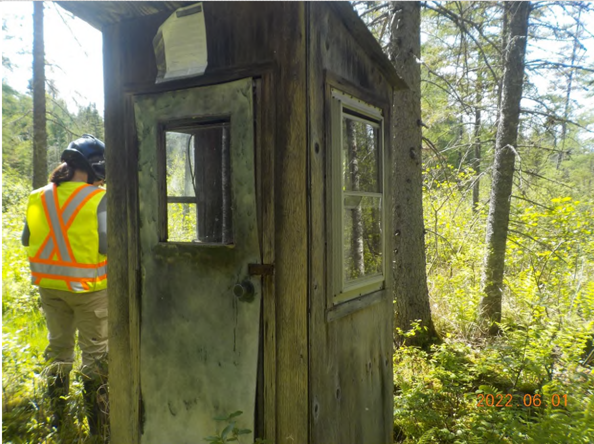
Figure 1: Structure à démanteler
