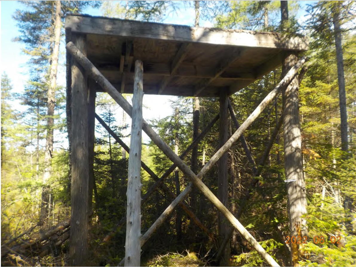
Figure 1: Plateforme à démanteler.
