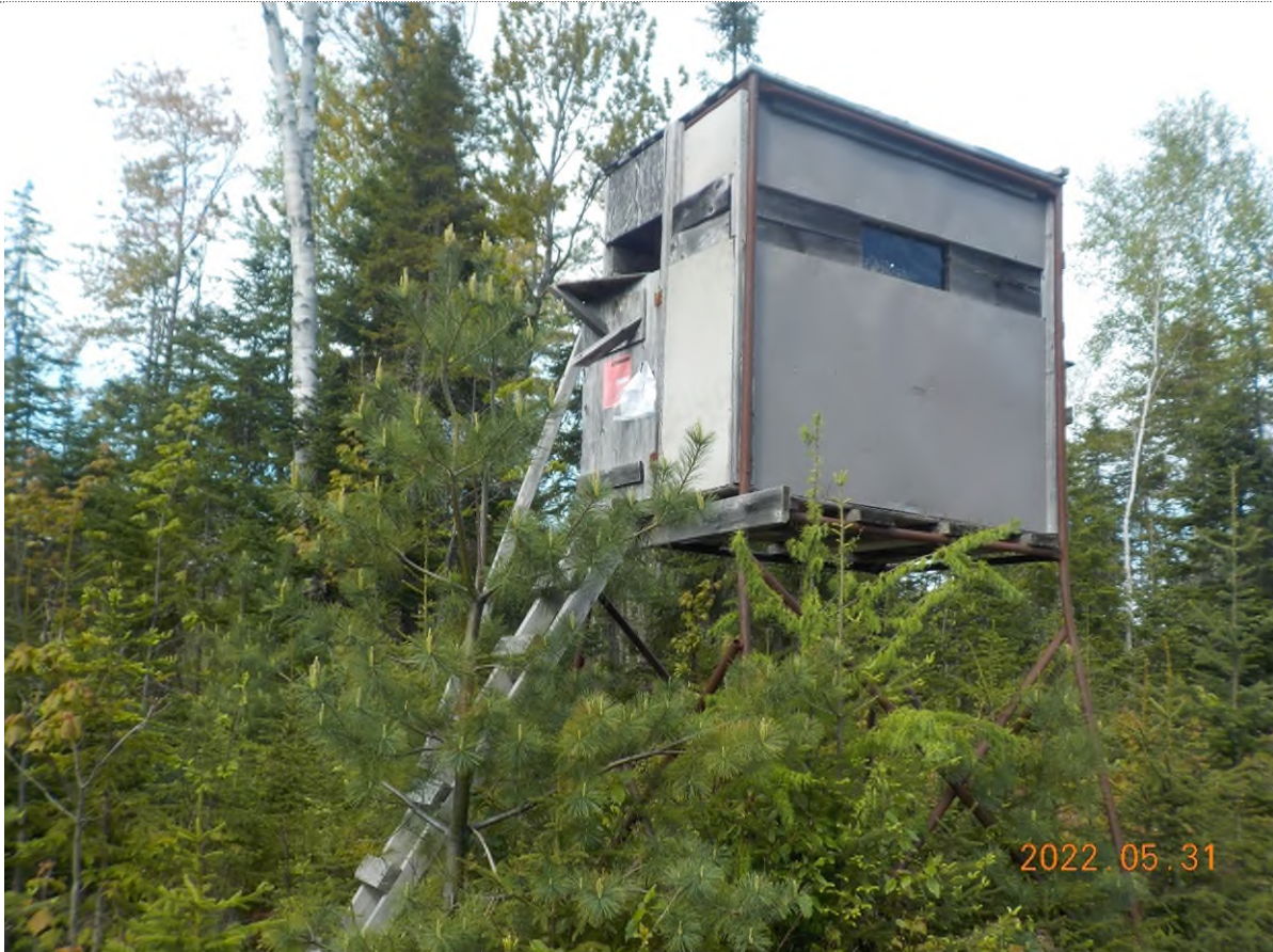
Figure 1: Structure à démanteler.
