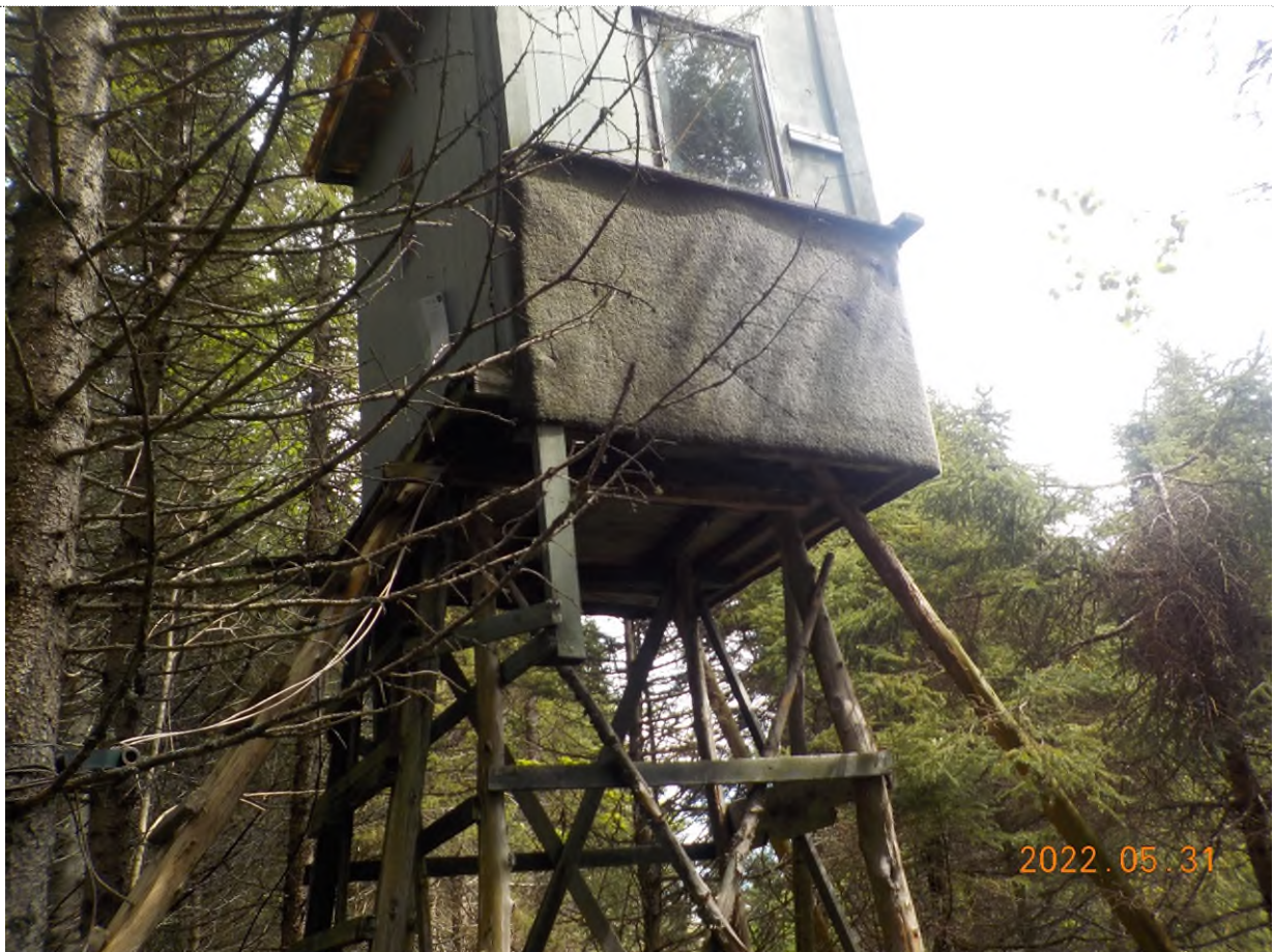
Figure 2 : Autre vue de la structure à démanteler.
