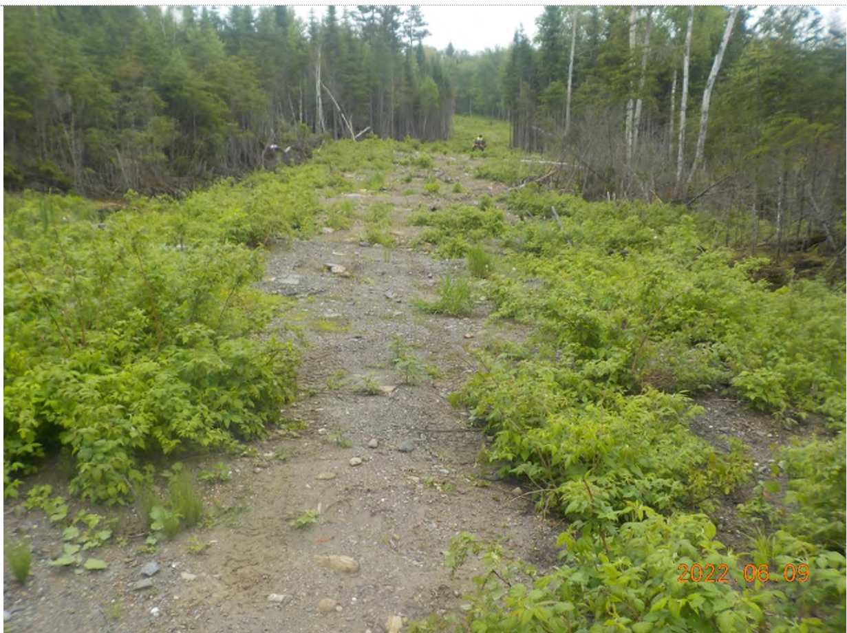
Figure 9: État du dernier 10m du chemin forestier
