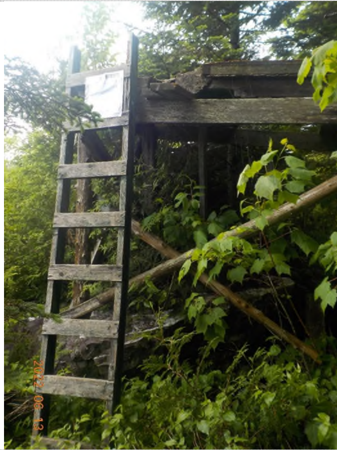
Figure 1: Plateforme à démanteler.
