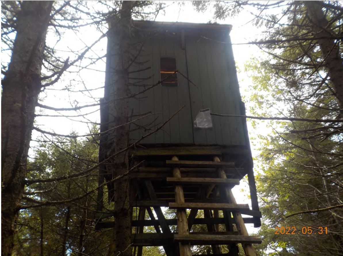
Figure 1 : Structure à démanteler.
