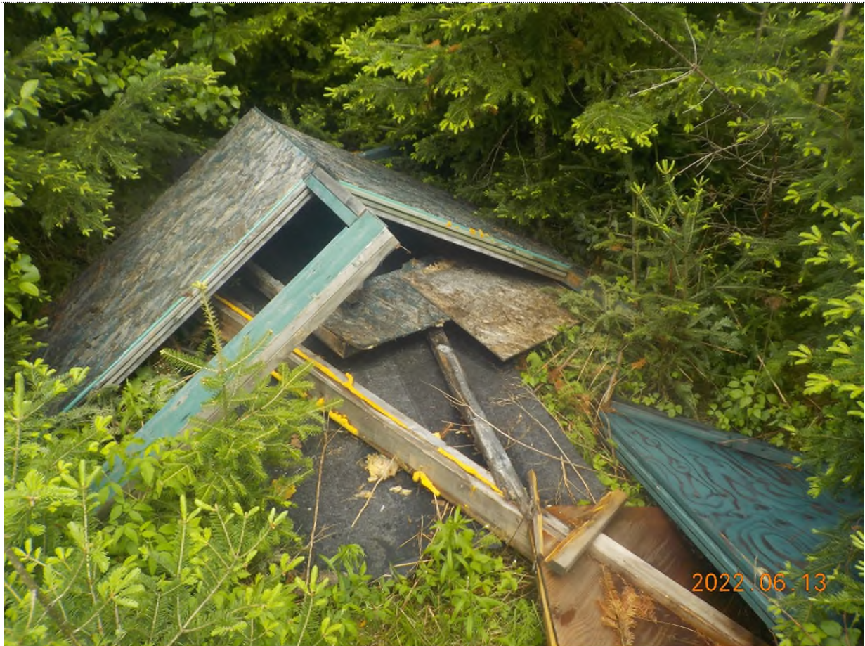
Figure 7: Débris à ramasser
