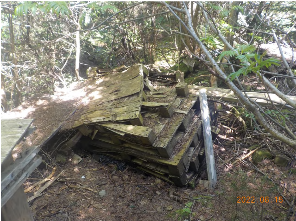
Figure 2: Débris à ramasser
