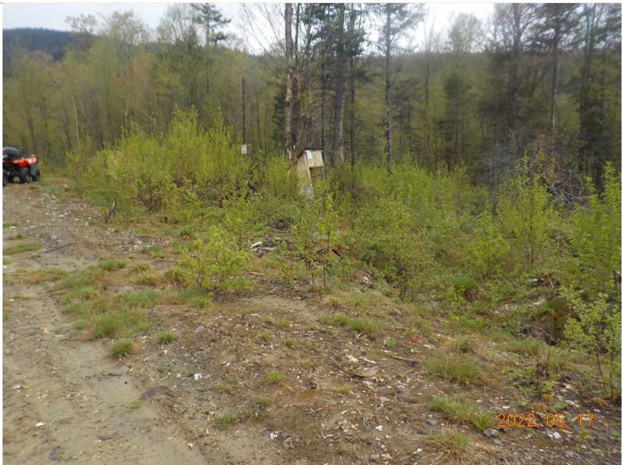
Figure 2: Sanitaire à démanteler vue du chemin forestier
