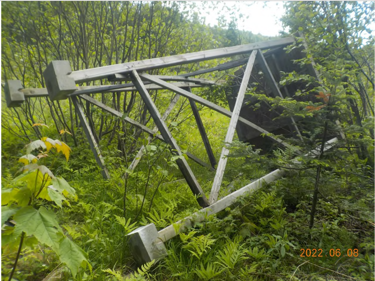
Figure 3: Plateforme à ramasser (4 bases de béton)
