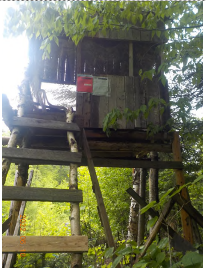
Figure 2: Cache à démanteler vue de derrière
