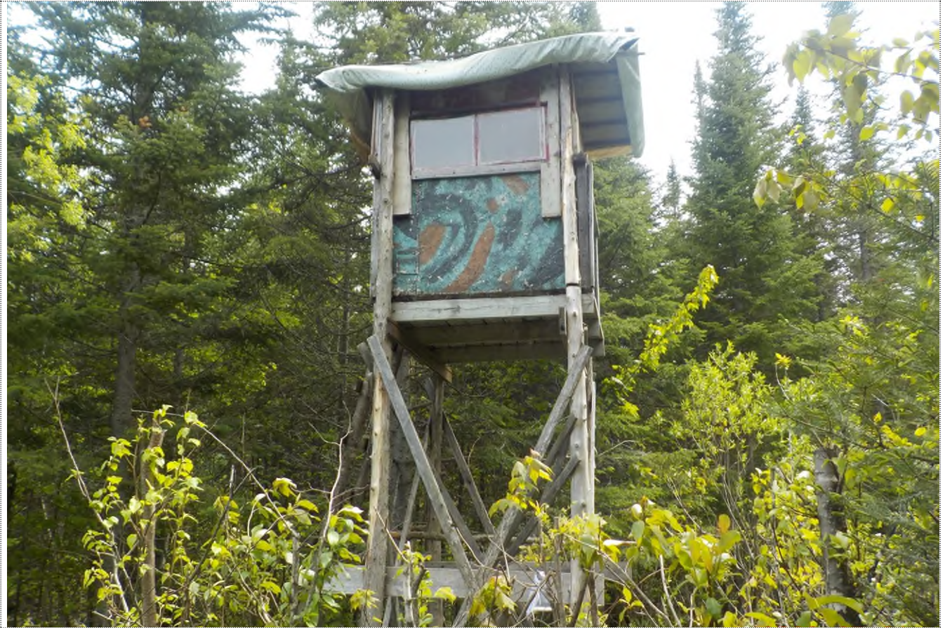
Figure 1 : Structure à démanteler.
