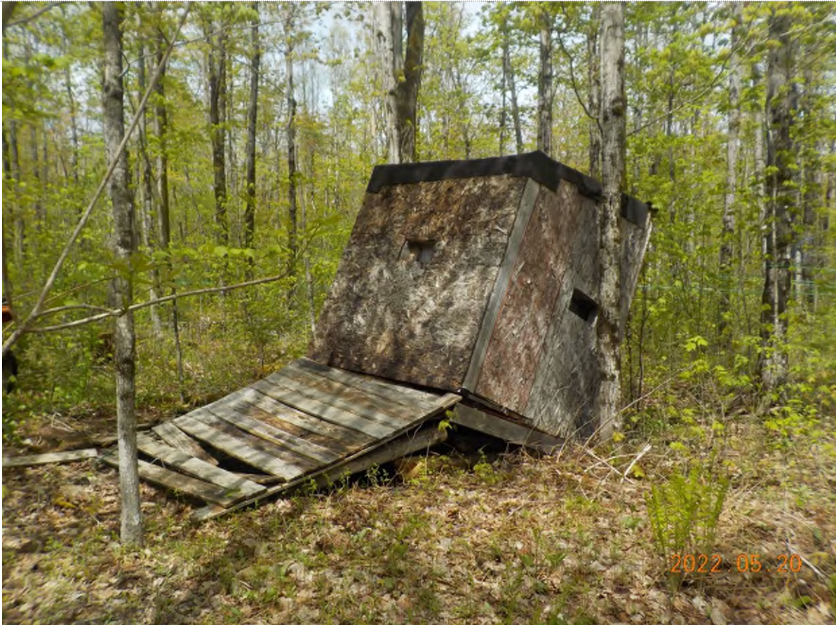
Figure 1: Structure abandonnée à démanteler
