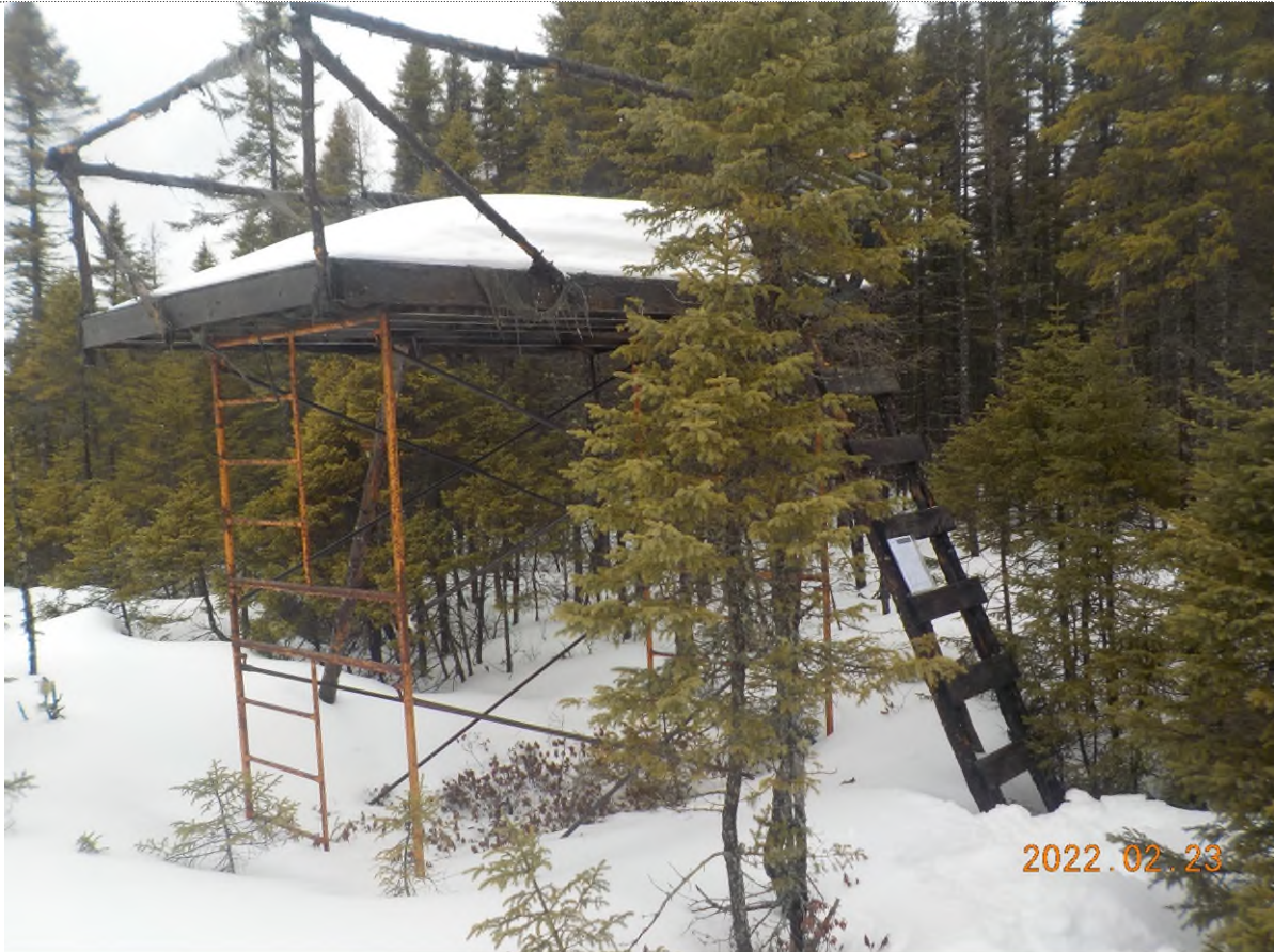
Figure 1 : Plateforme à démanteler.
