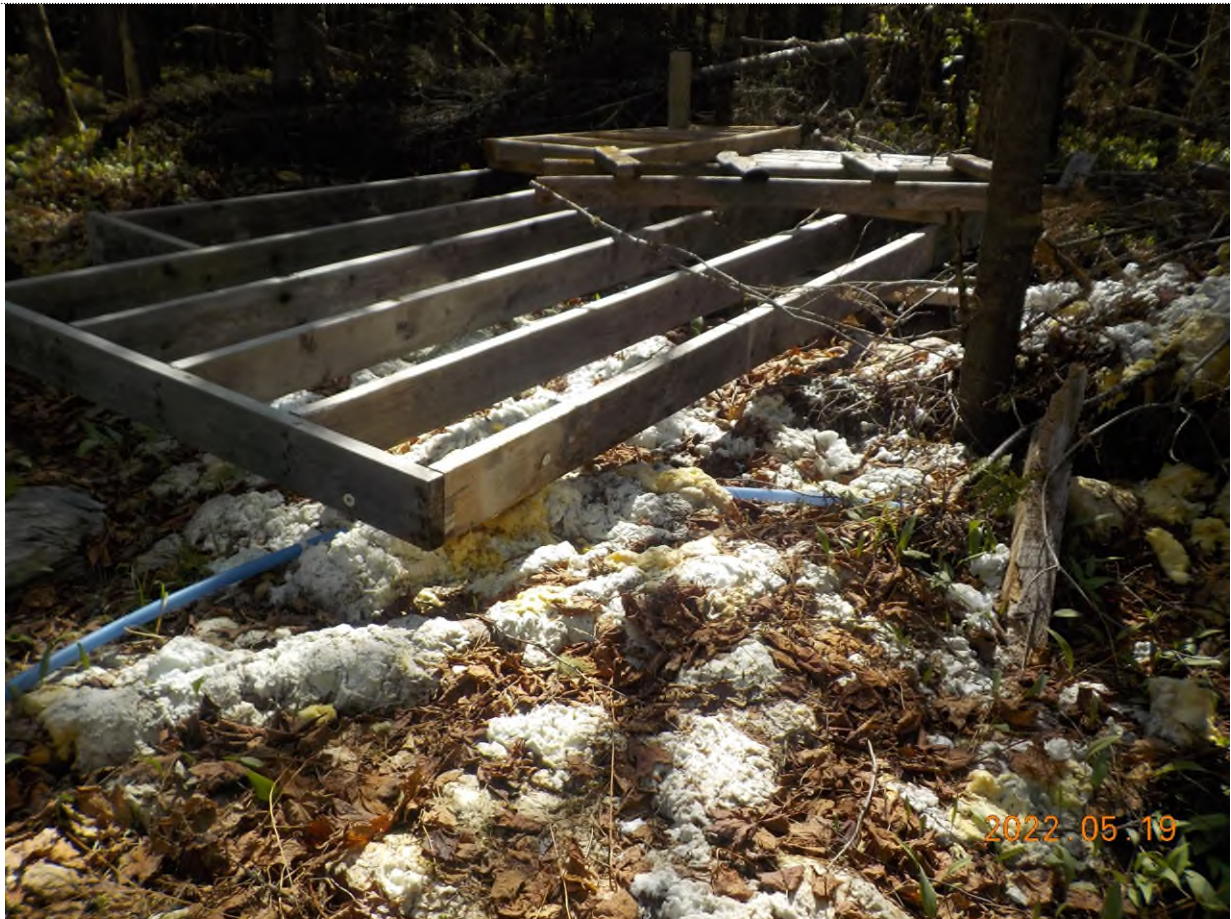
Figure 3: Débris à ramasser
