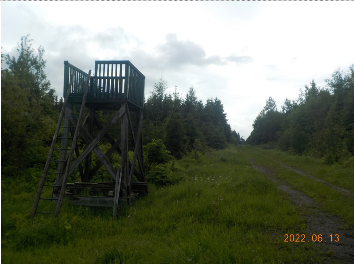
Figure 1: Tour de guet à démanteler et état du chemin forestier
