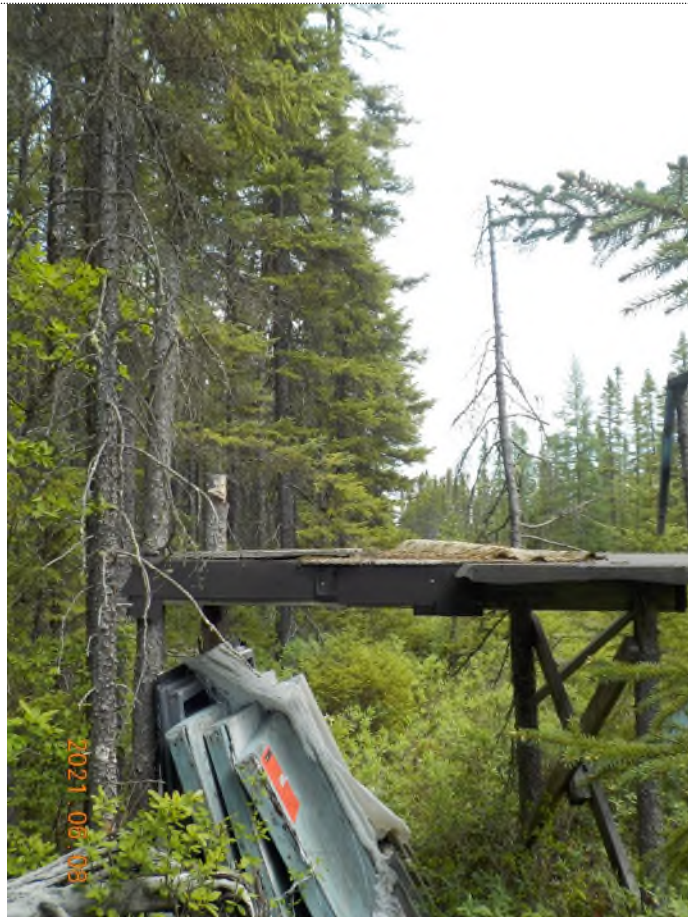
Figure 2 : Plate-forme et cache démontée à ramasser
