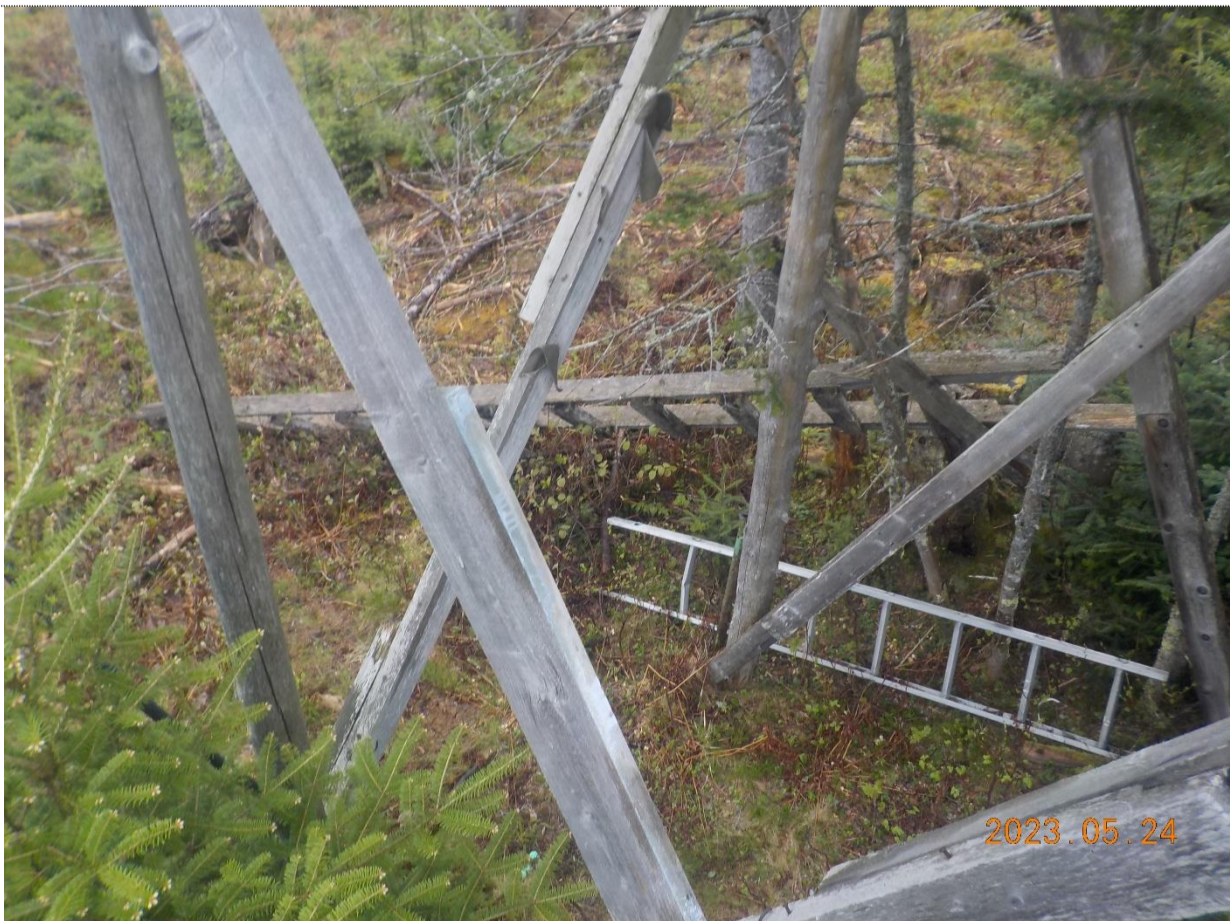
Figure 5: Débris / matériaux sous la cache à ramasser
