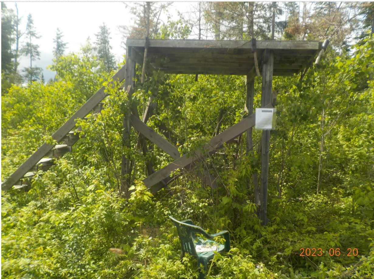
Figure 2: Plateforme à démanteler.
