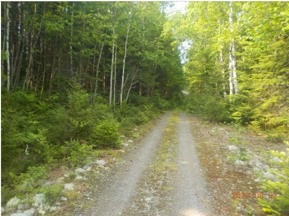
Figure 8: État du chemin en VTT
