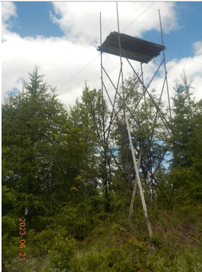
Figure 1: Structure d'acier à démanteler.
