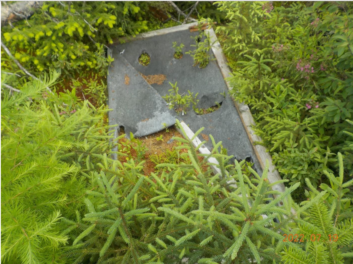
Figure 3: Débris autour de la structure à ramasser
