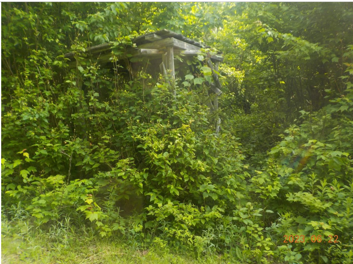
Figure 2: Structure à démanteler 350634-A.
