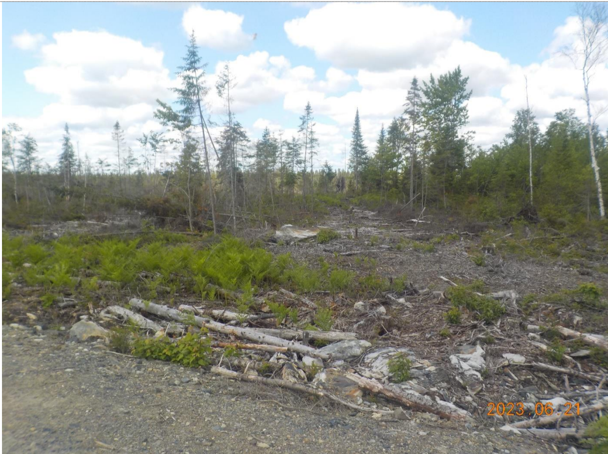
Figure 3: Entrée de l'accès en VTT (débardage)
