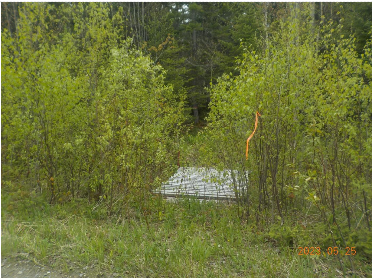
Figure 8: Entrée du sentier VTT et pont de bois à démanteler (610013-C).
