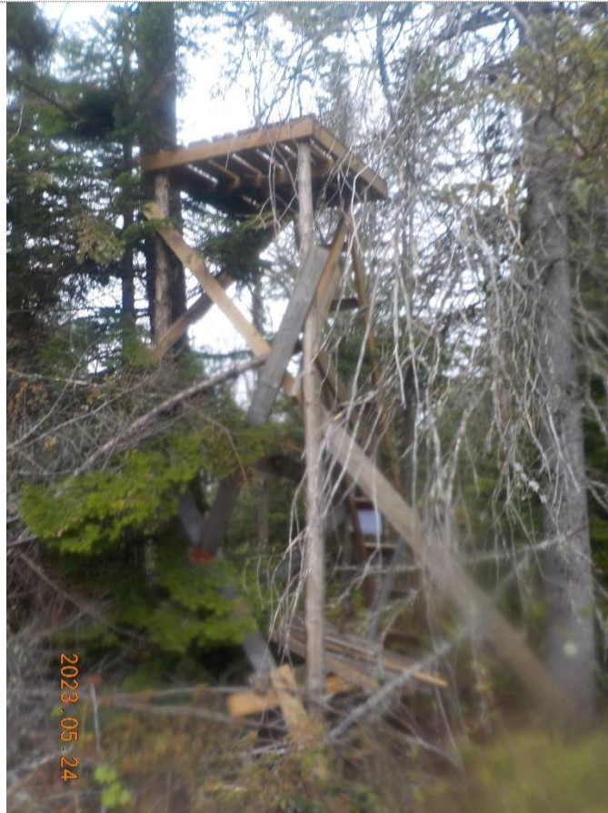
Figure 1: Plateforme à démanteler.
