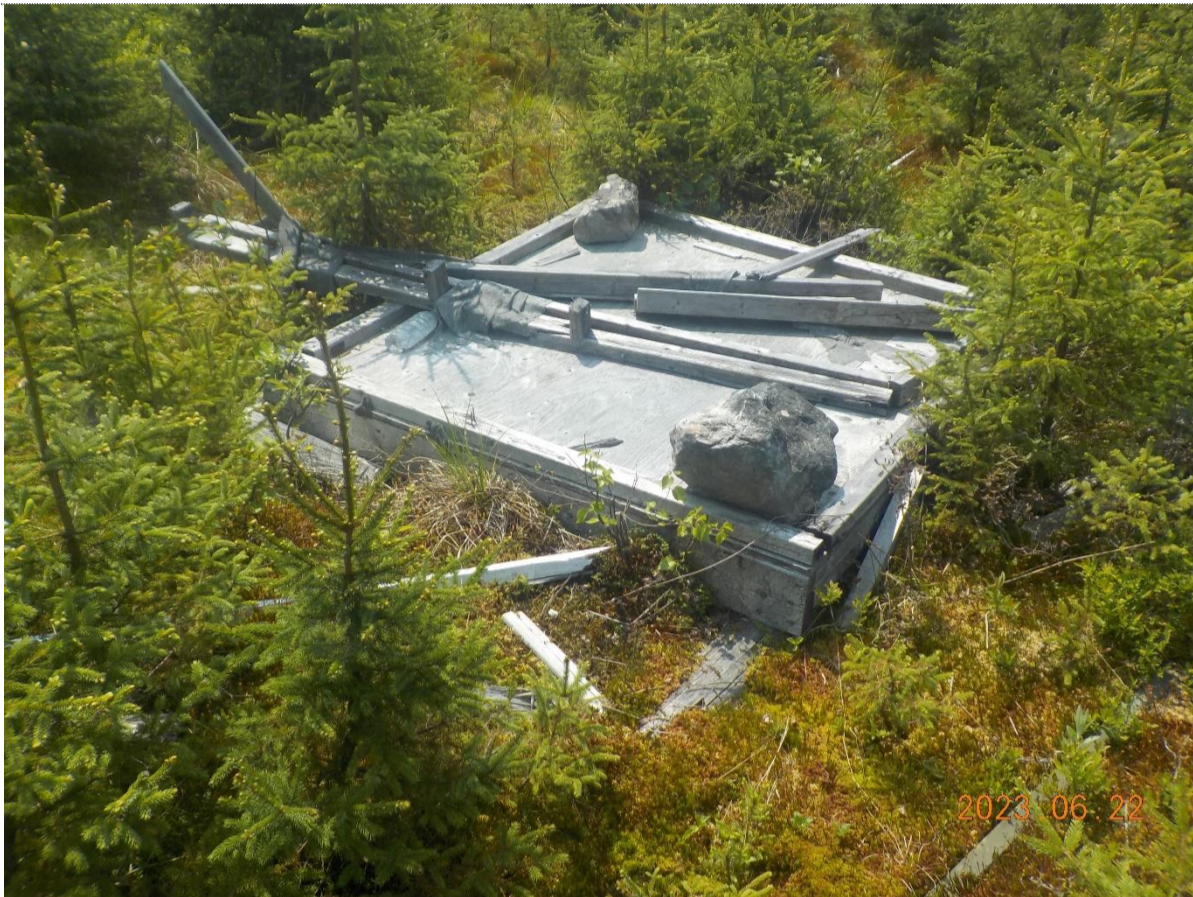
Figure 1: Structure abandonnée à ramasser.
