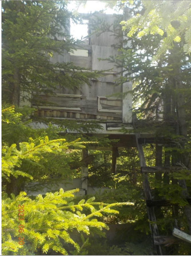
Figure 1: Structure abandonnée à démanteler
