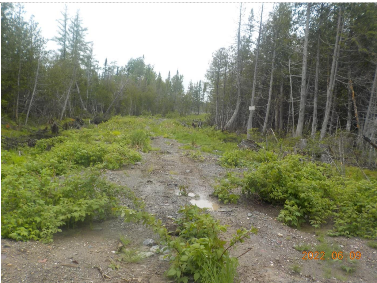
Figure 8 : État du chemin forestier d'hiver (accès VTT)
