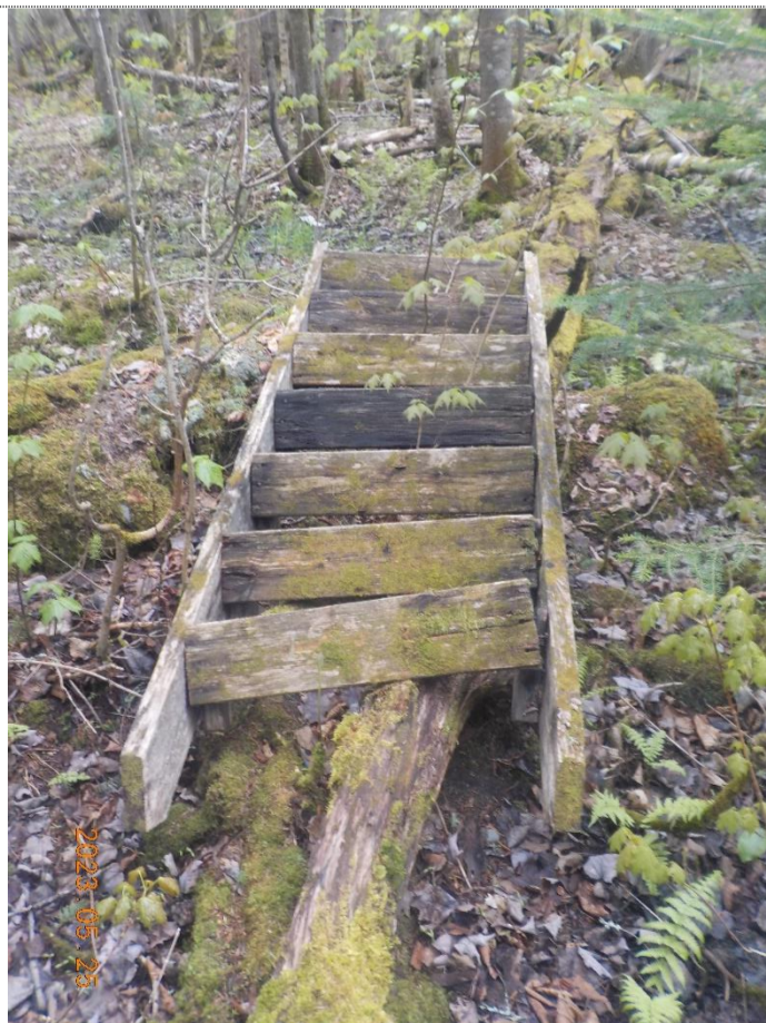
Figure 6: Vieille échelle en bois à ramasser (610013-A).
