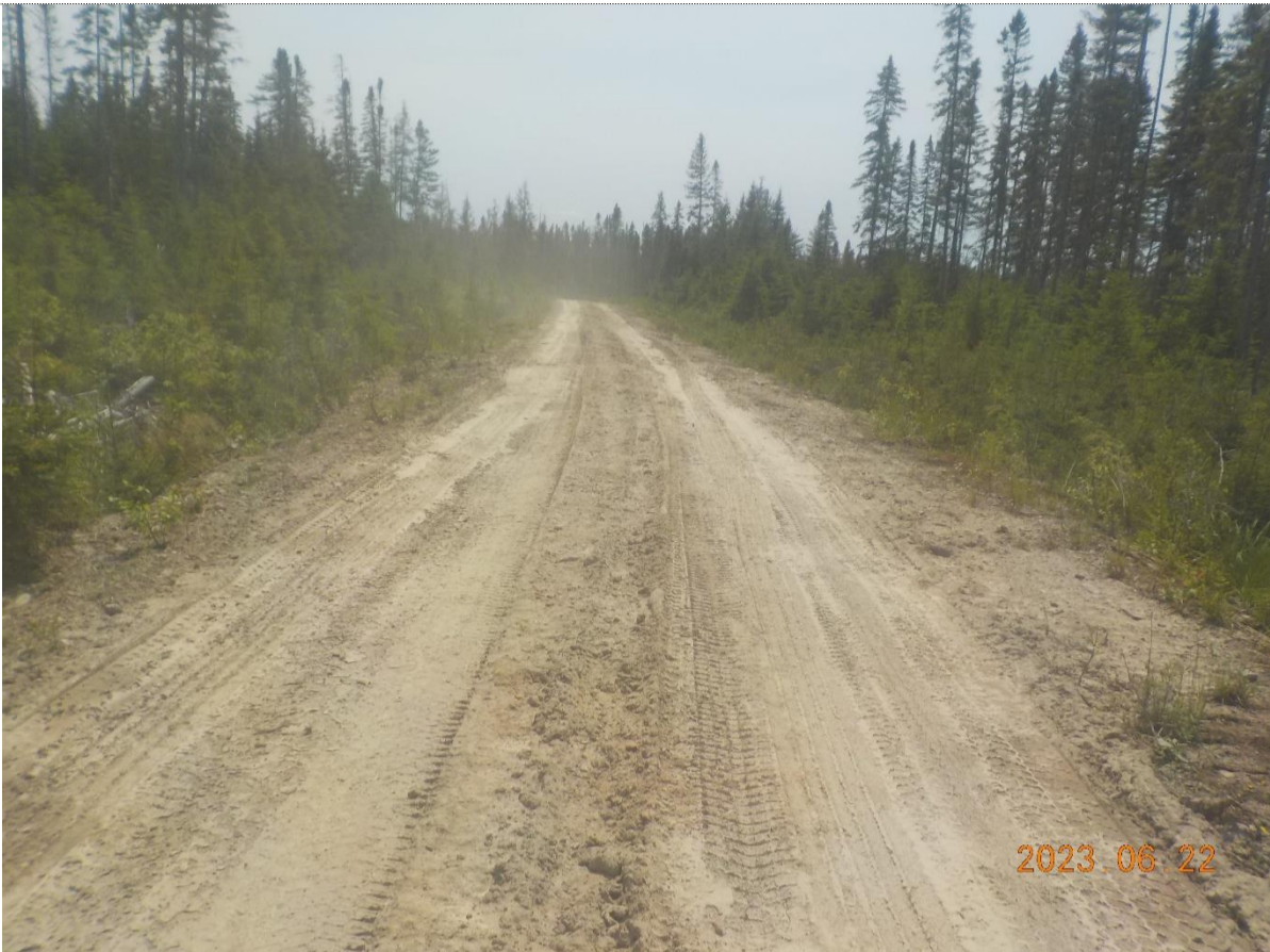
Figure 3: État du chemin
