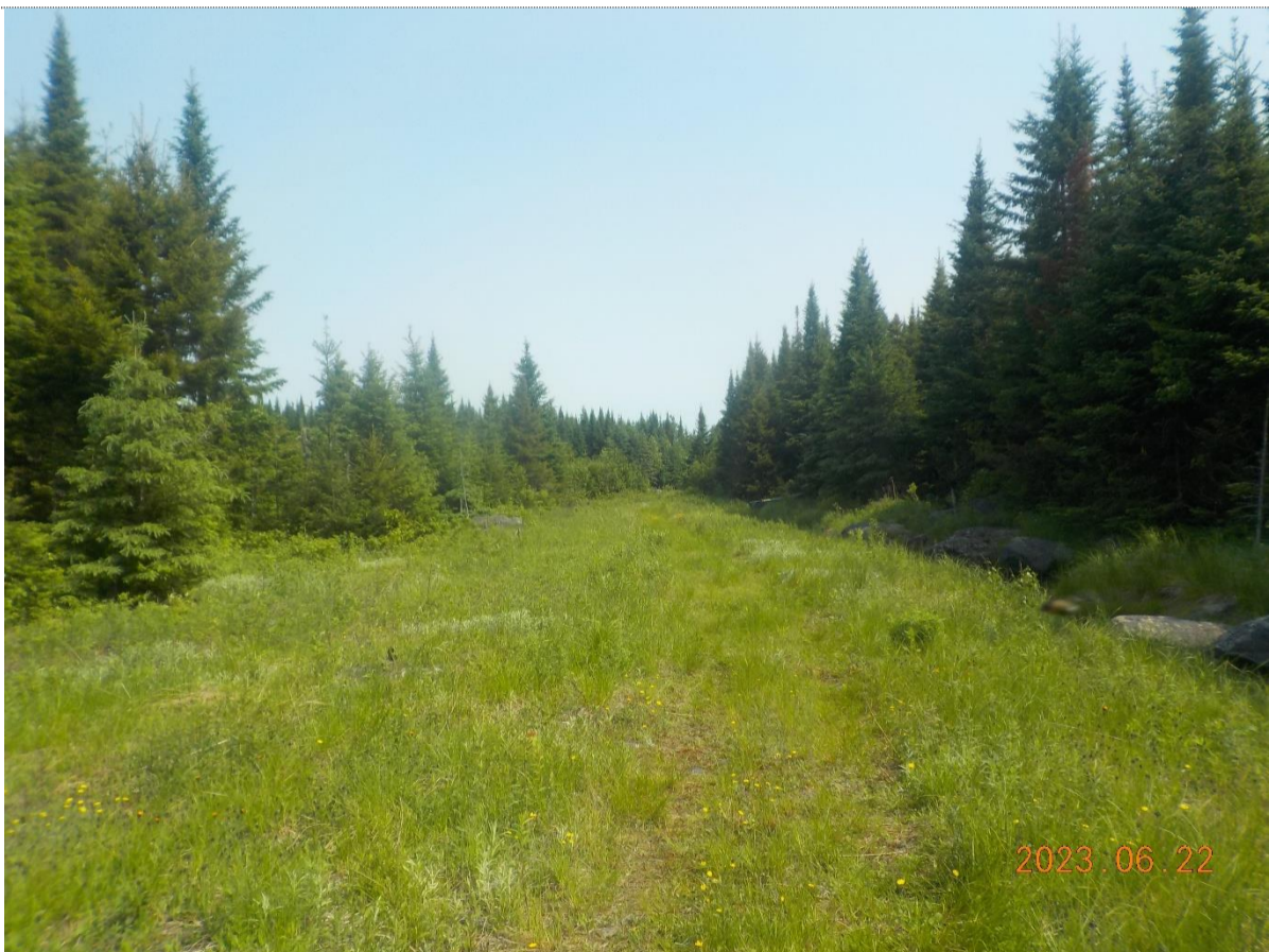
Figure 14 : État du sentier du chemin entre 350627 et 350627-B
