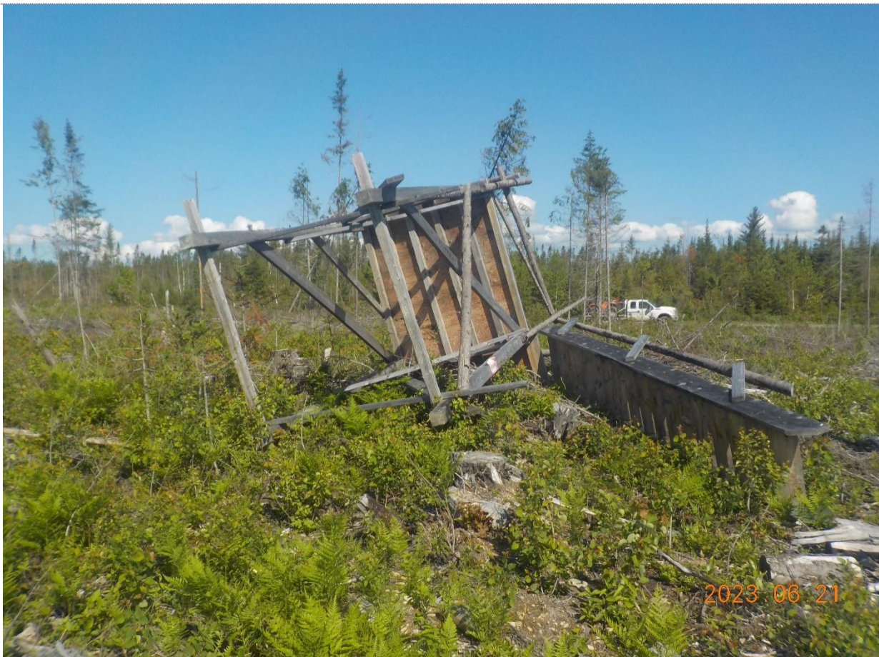
Figure 2: Plateforme à démanteler.
