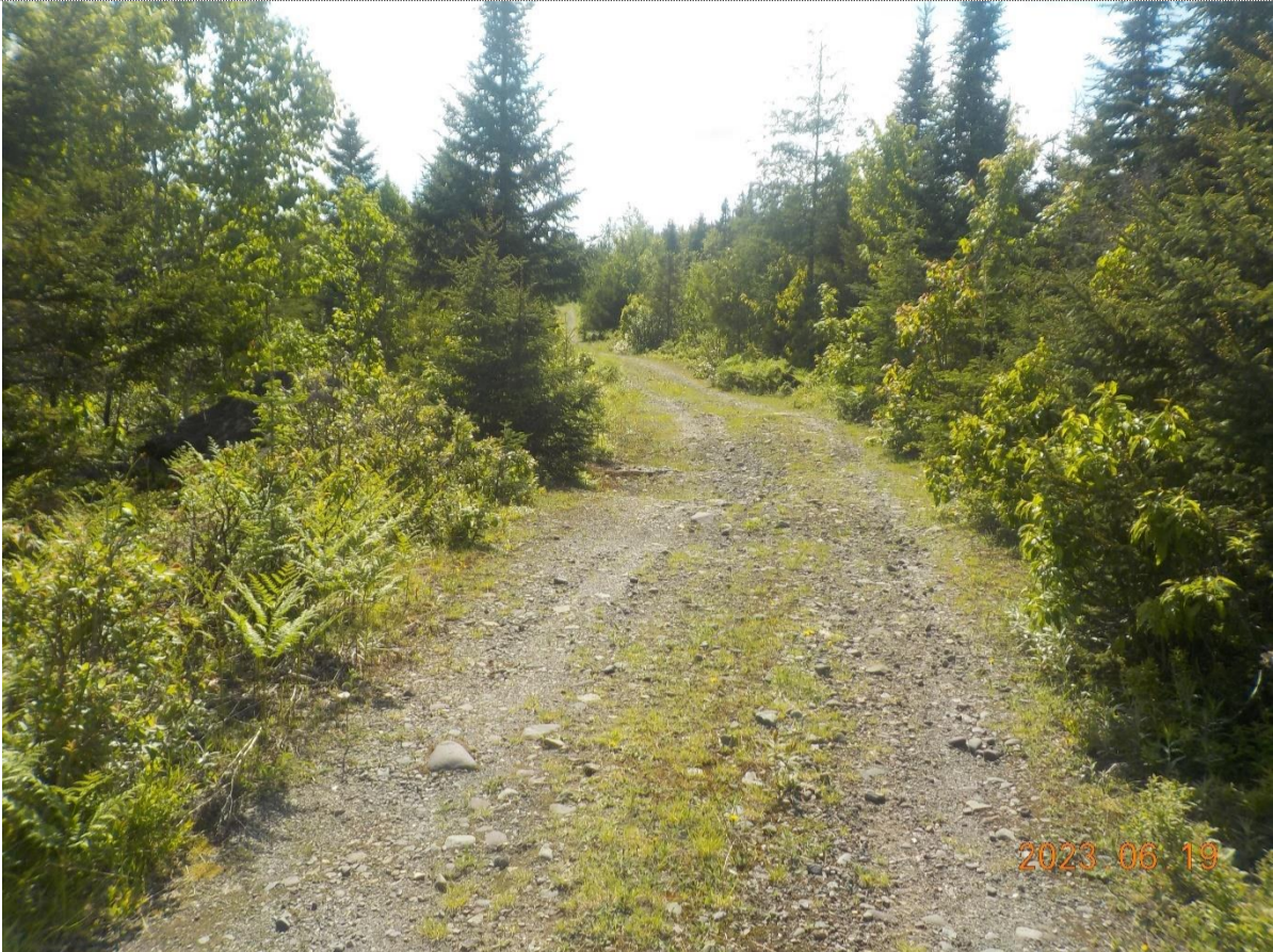
Figure 5: État du chemin forestier secondaire
