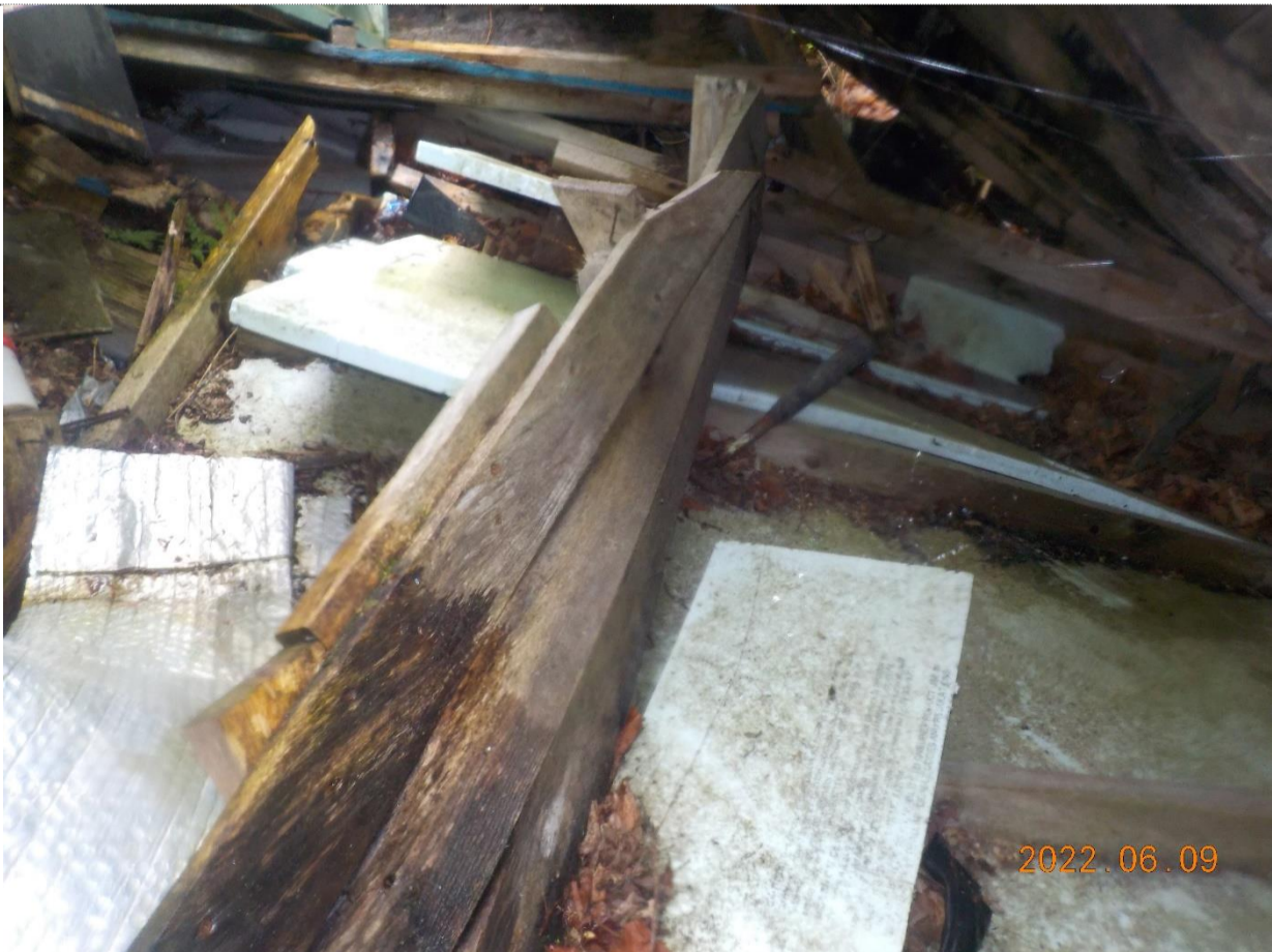
Figure 4 : Intérieur de la structure
