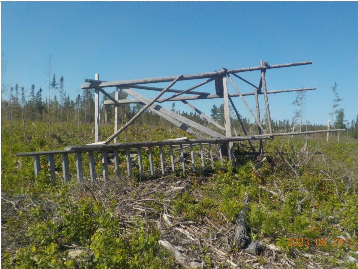
Figure 1: Plateforme à démanteler.
