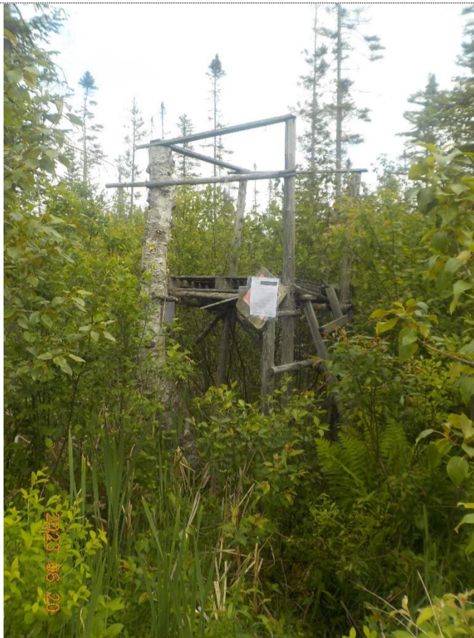
Figure 1: Structure à ramasser.
