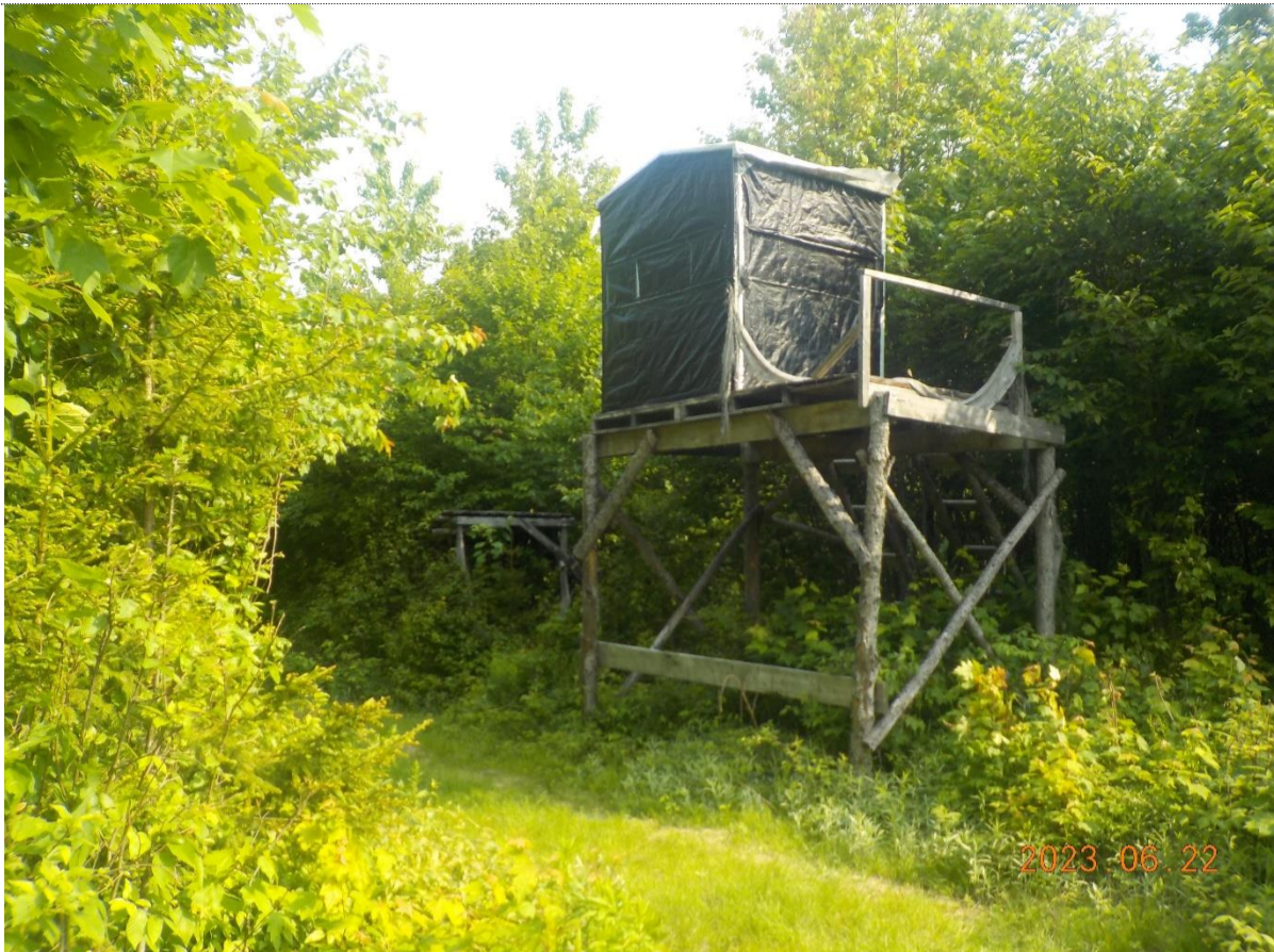
Figure 3: Vue d'ensemble des structures à démanteler.
