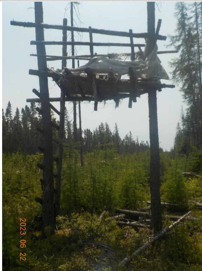
Figure 2: Autre vue de la structure abandonnée à ramasser.
