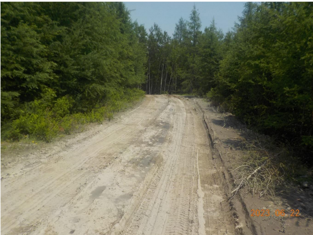
Figure 4: État du chemin
