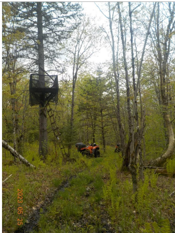
Figure 2: Ex.: Plateforme à démanteler.
