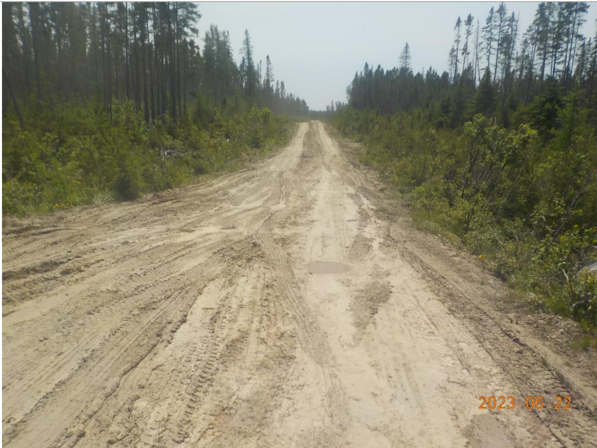
Figure 3: État du chemin
