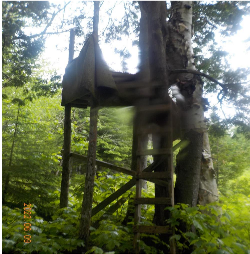
Figure 1 : Structure abandonnée à démanteler.
