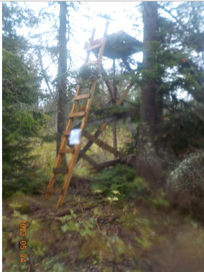
Figure 2: Plateforme à démanteler (autre vue).
