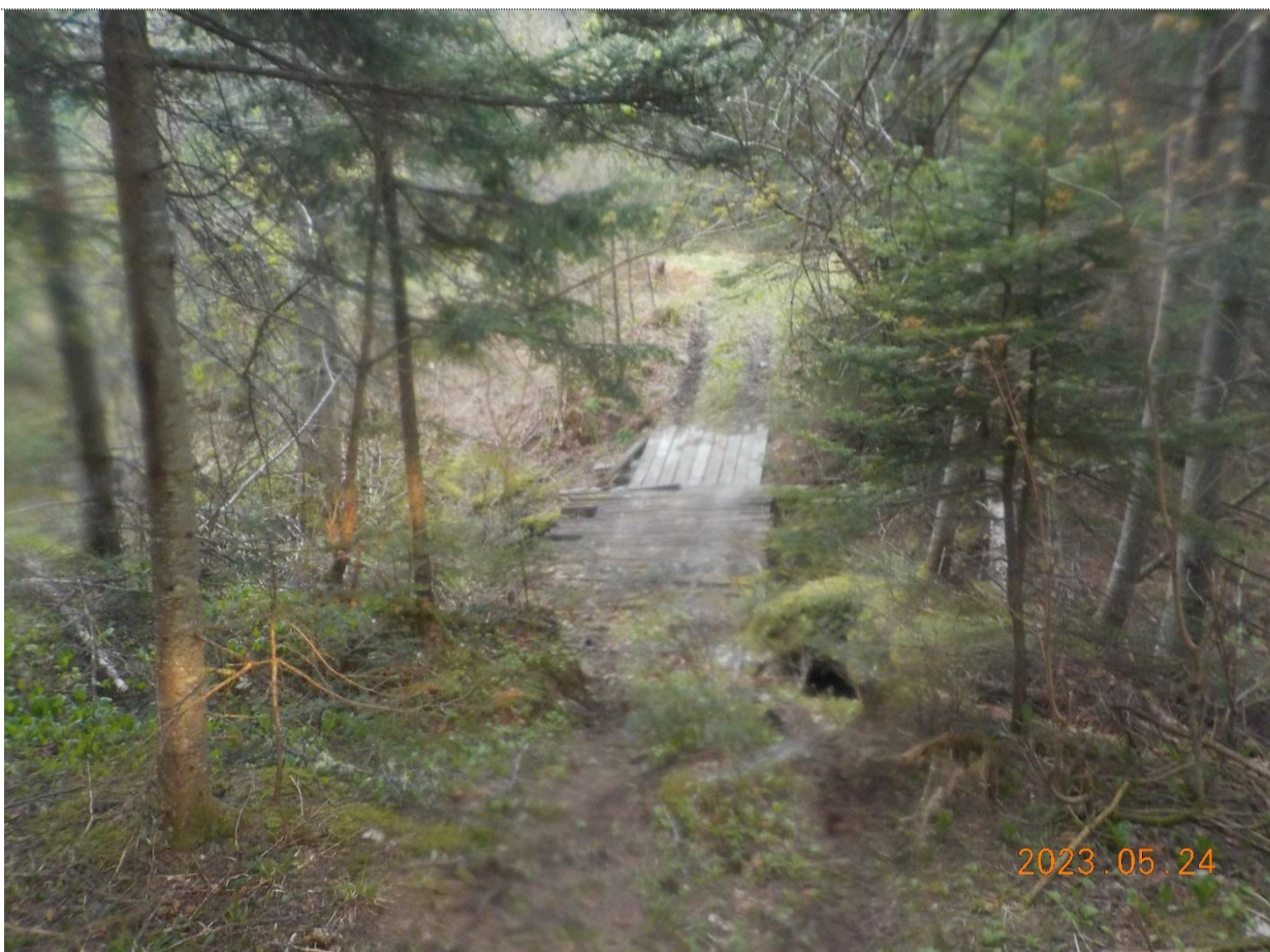
Figure 14: Vue du pont VTT à traverser
