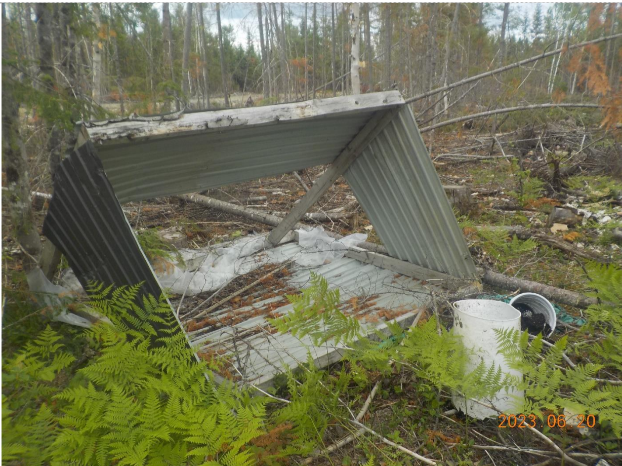
Figure 2: Structure abandonnée et débris à ramasser
