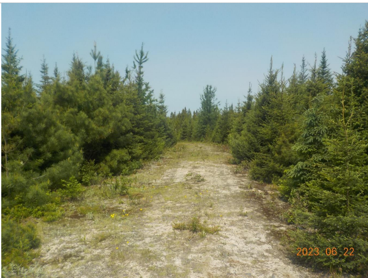
Figure 10: État du chemin forestier secondaire
