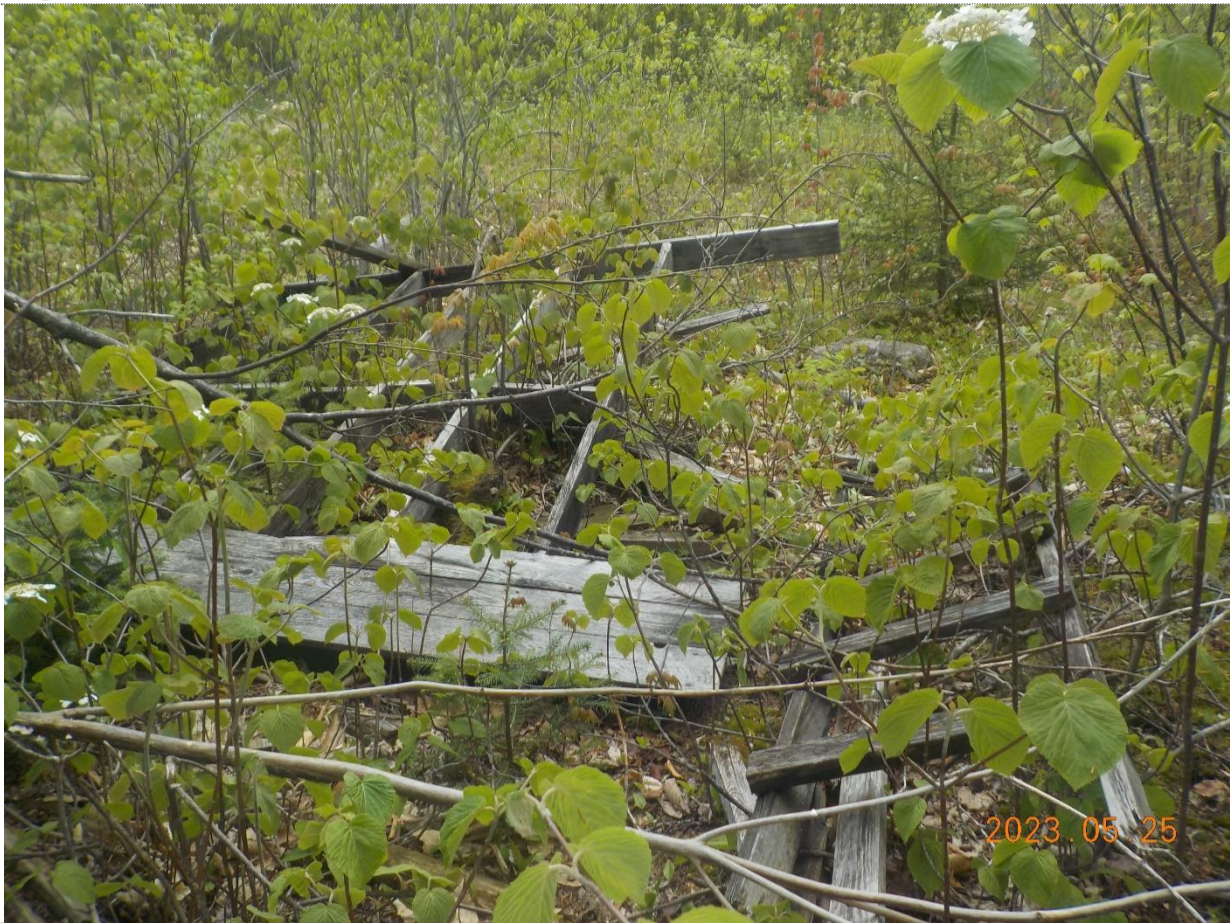
Figure 3: Débris / Matériaux à ramasser près de la structure principale
