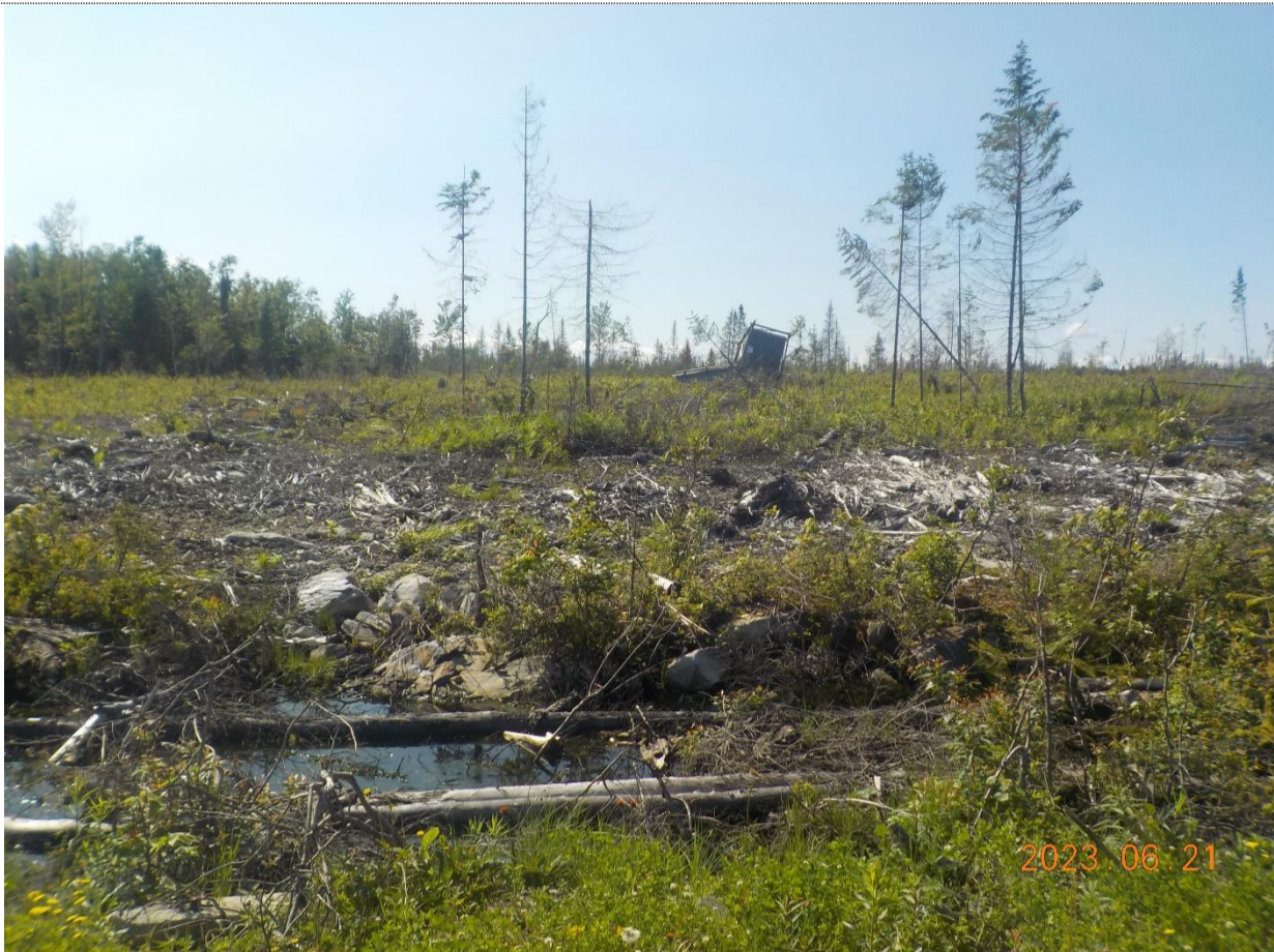
Figure 3: Plateforme à démanteler et vue de l'accès en VTT à partir du chemin.
