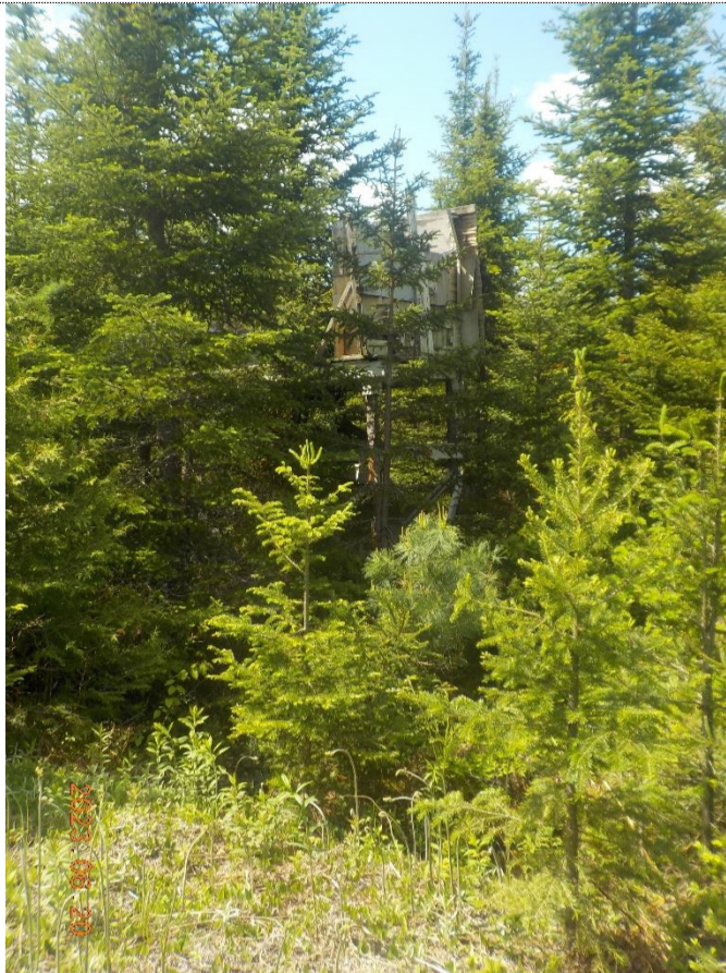
Figure 3: Structure abandonnée à démanteler (vue du chemin forestier)
