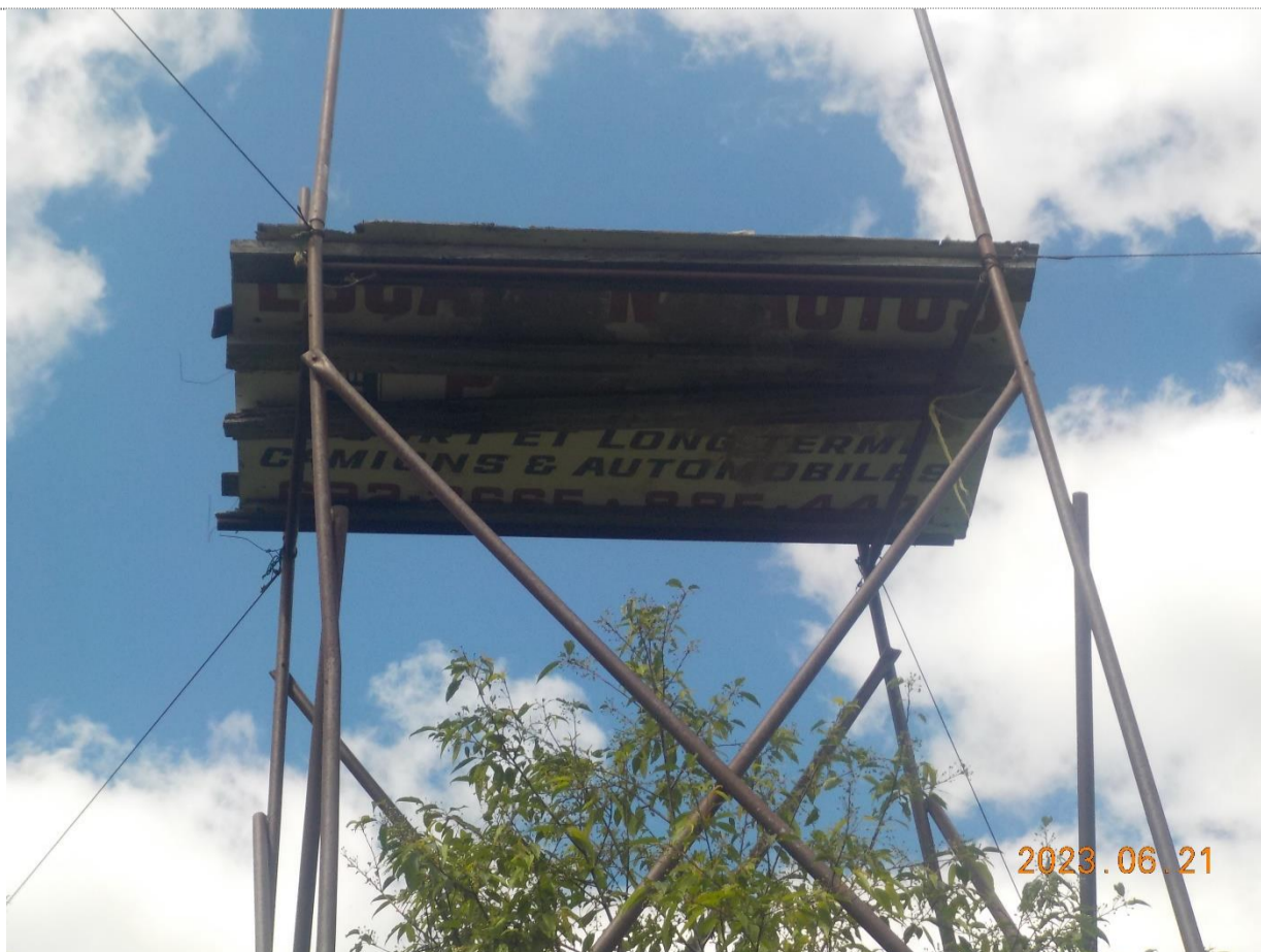
Figure 2: Vue rapprochée de la structure
