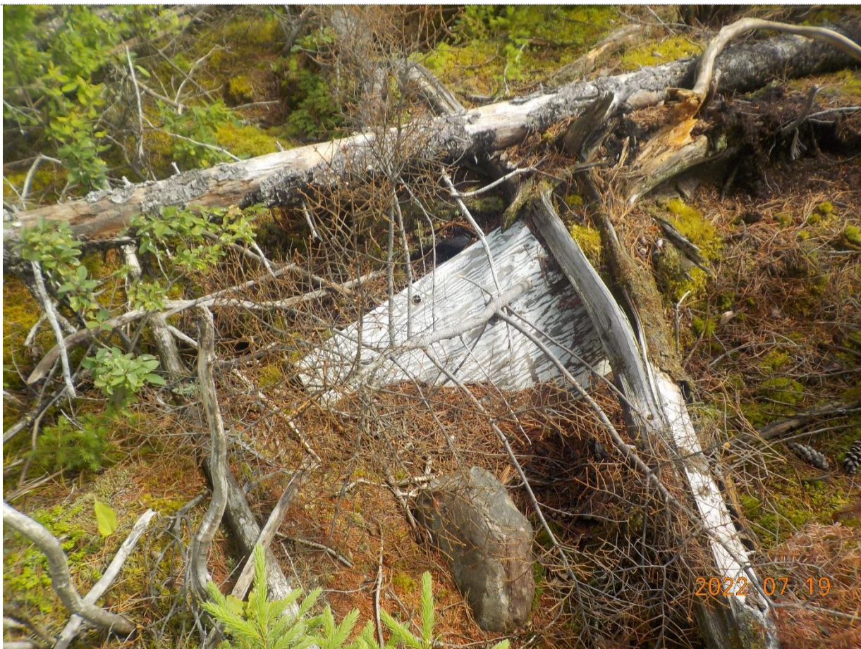
Figure 2: Débris autour de la tour de guet à ramasser.
