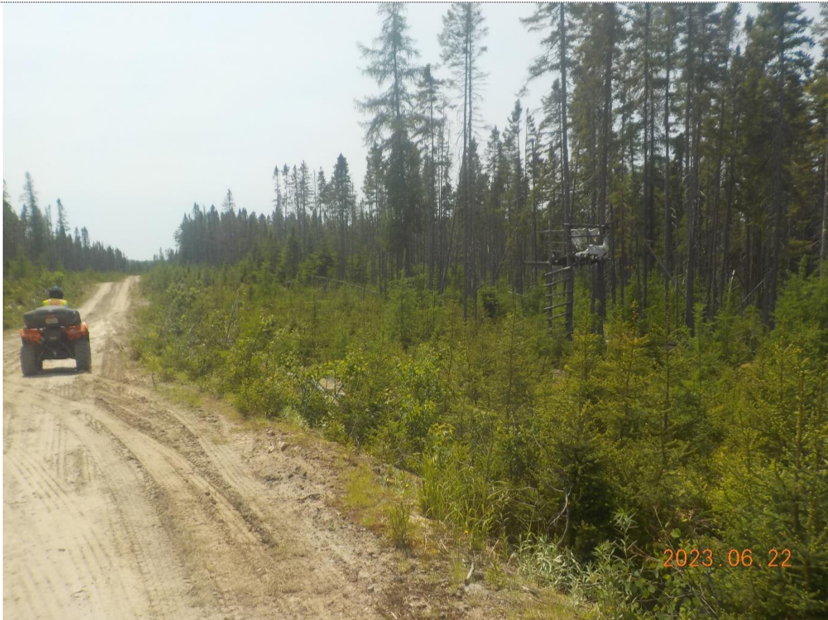
Figure 3: Structure vue du chemin
