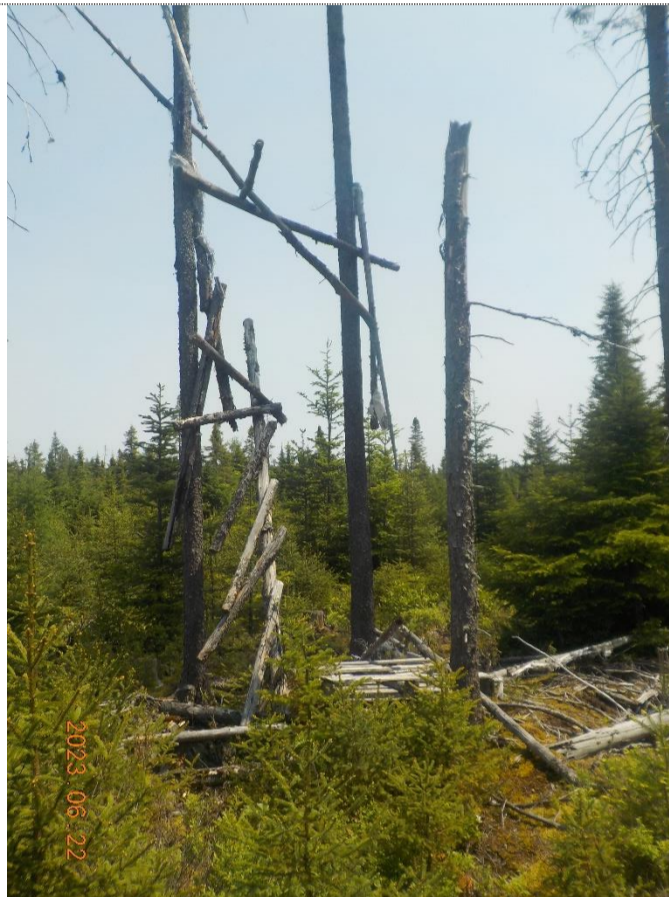
Figure 1: Structure abandonnée à ramasser.
