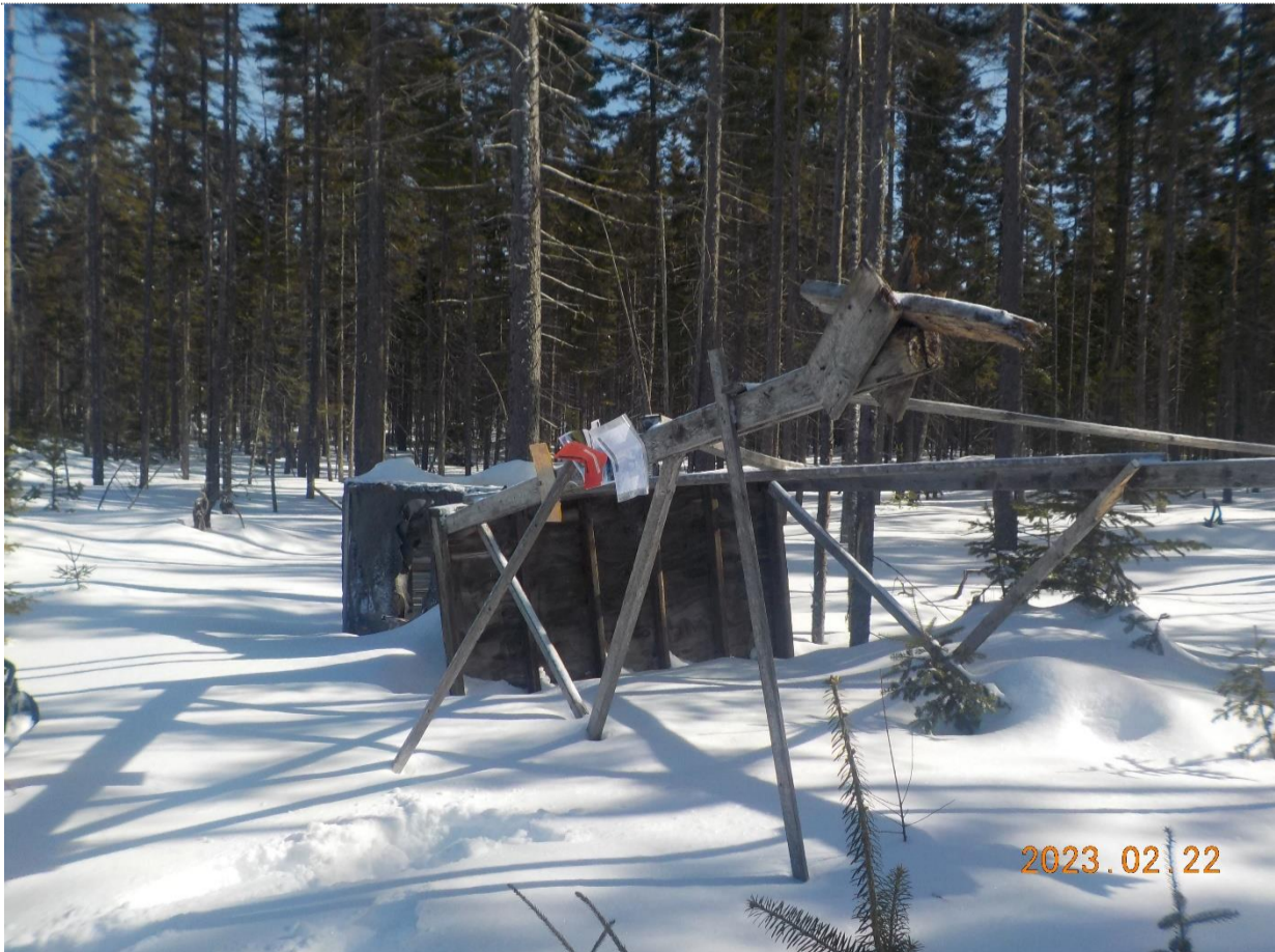
Figure 2: Vue de la structure à ramasser (État actuel).
