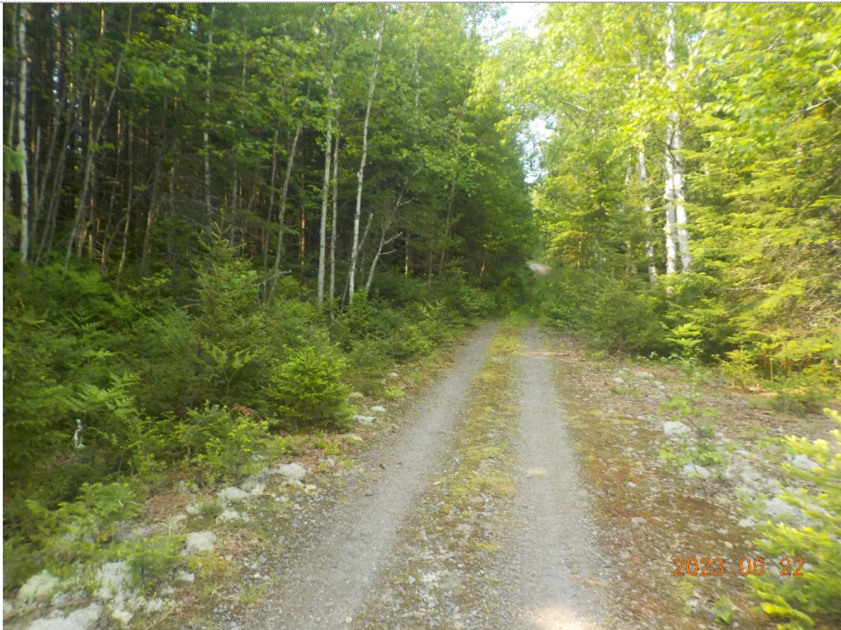
Figure 5: État du chemin en VTT
