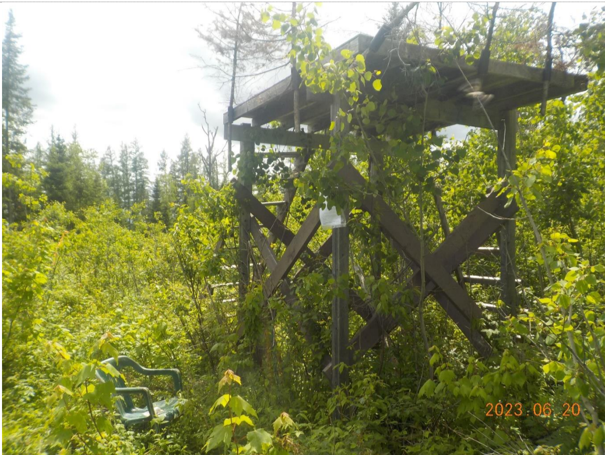
Figure 1: Plateforme à démanteler.
