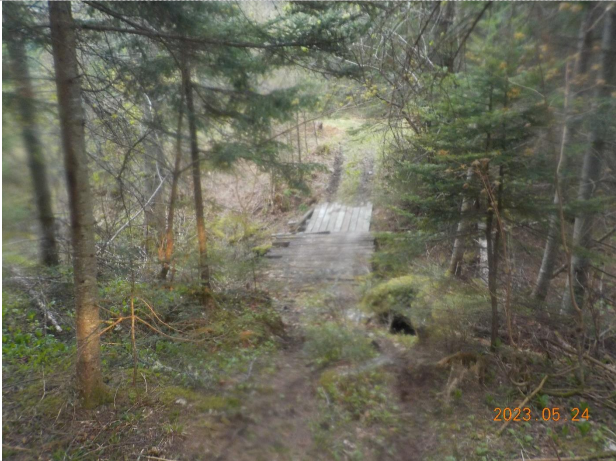
Figure 11: Vue du pont VTT à traverser
