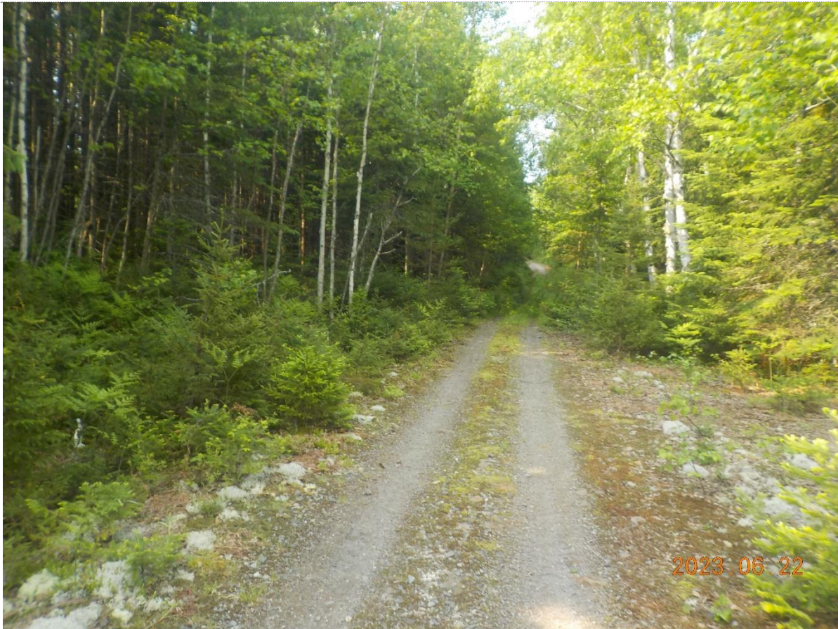
Figure 9: État du chemin en VTT
