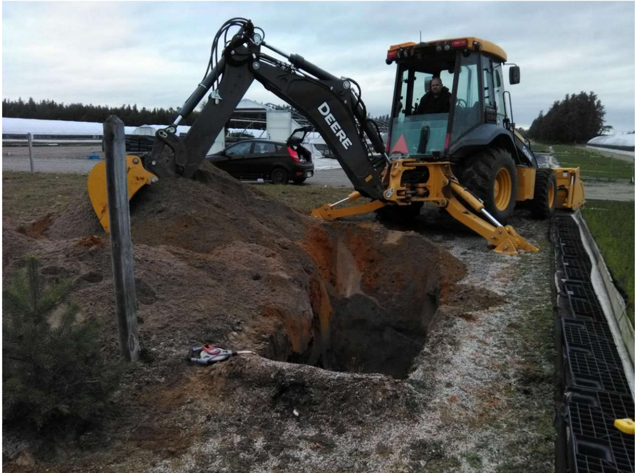
Photo 6: Puits d'exploration PU-02-21 – réalisation de l'excavation
