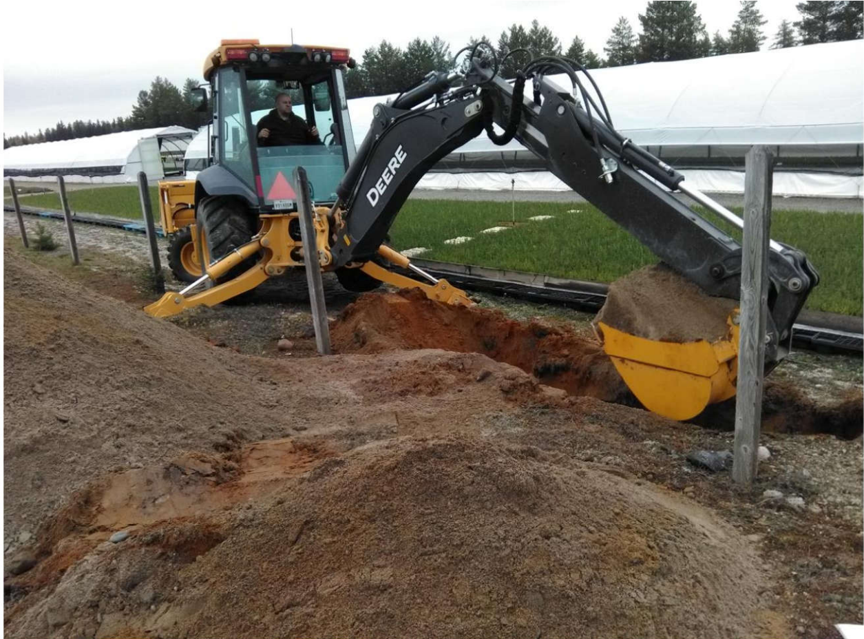
Photo 1: Puits d'exploration PU-01-21 – réalisation de l'excavation
