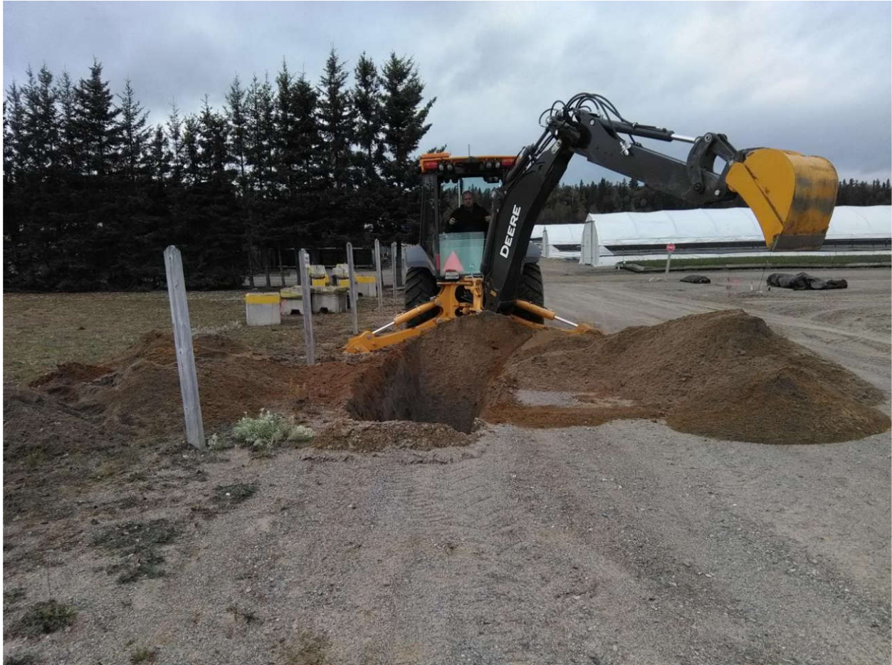
Photo 11: Puits d'exploration PU-03-21 – réalisation de l'excavation
