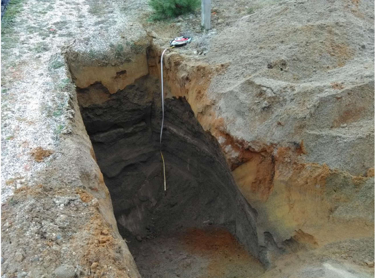
Photo 7: Puits d'exploration PU-02-21 – parois et fond d'excavation
