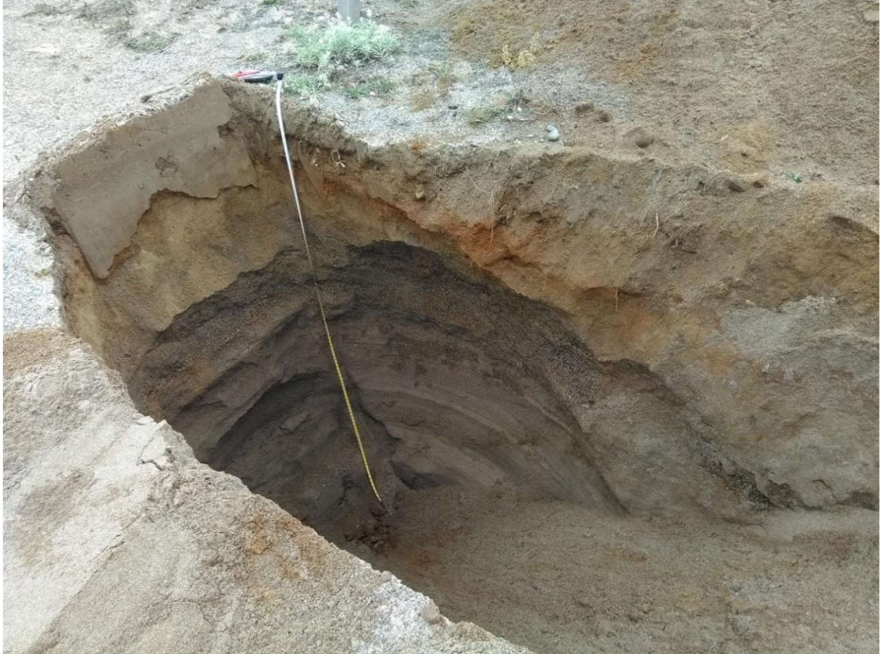
Photo 12: Puits d'exploration PU-03-21 – parois et fond d'excavation
