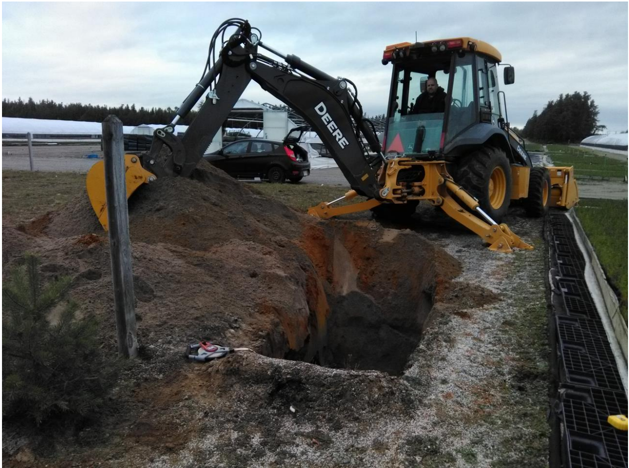
Photo 6: Puits d'exploration PU-02-21 – réalisation de l'excavation
