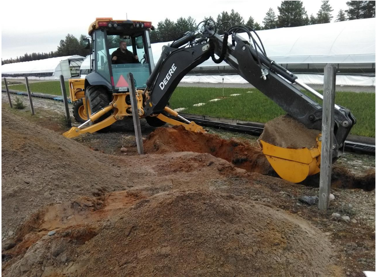
Photo 1: Puits d'exploration PU-01-21 – réalisation de l'excavation
