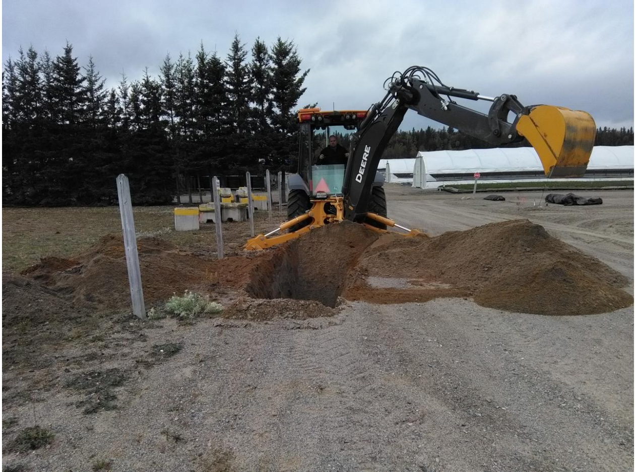
Photo 11: Puits d'exploration PU-03-21 – réalisation de l'excavation
